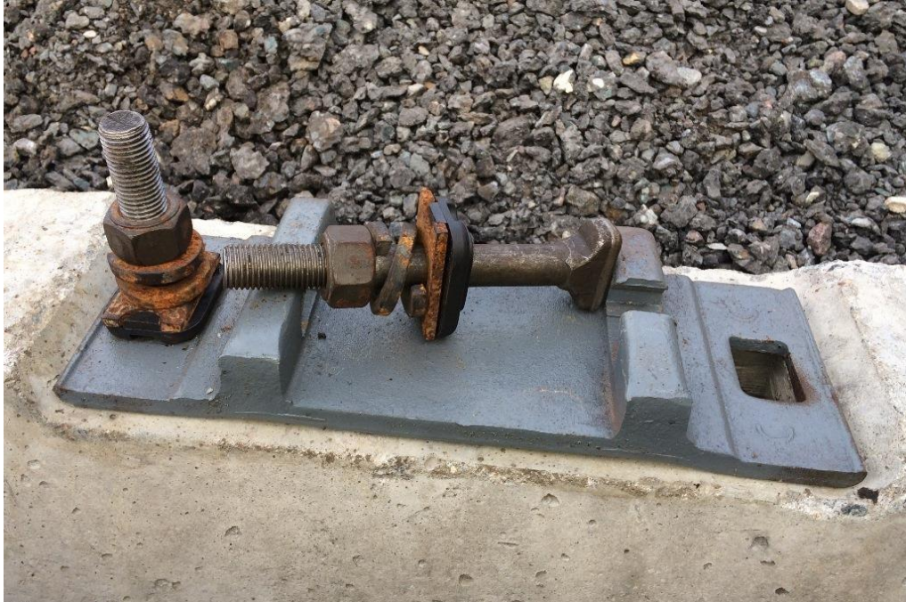
Рис. 2.2. Комплект (бовт закладний, втулка ізолююча, скоби, шайба) та металева підкладка на залізобетонній шпалі
