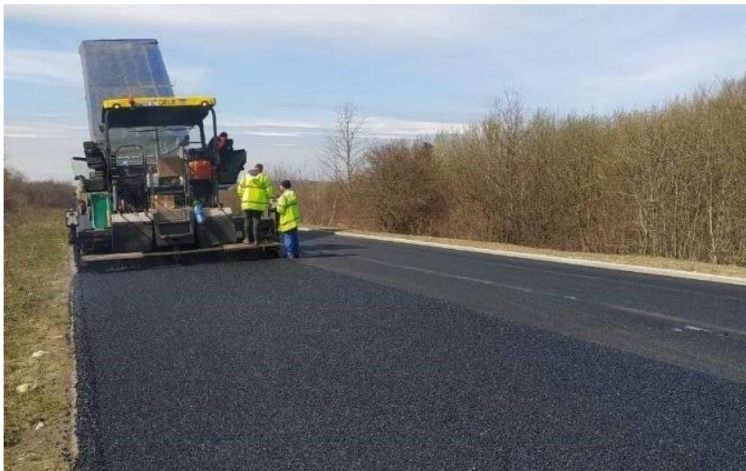
Рисунок 1.3 – Укладання асфальтобетонного покриття
