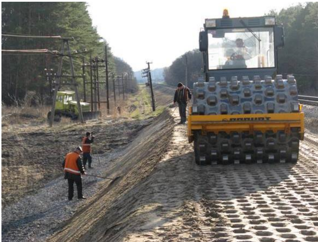
Рисунок 4.4 – Ущільнення ґрунту при відсипанні насипу
