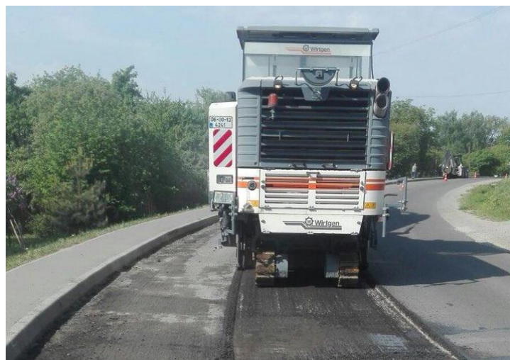
Рисунок 1.2 – Підготовка дороги до укладання асфальтобетону
