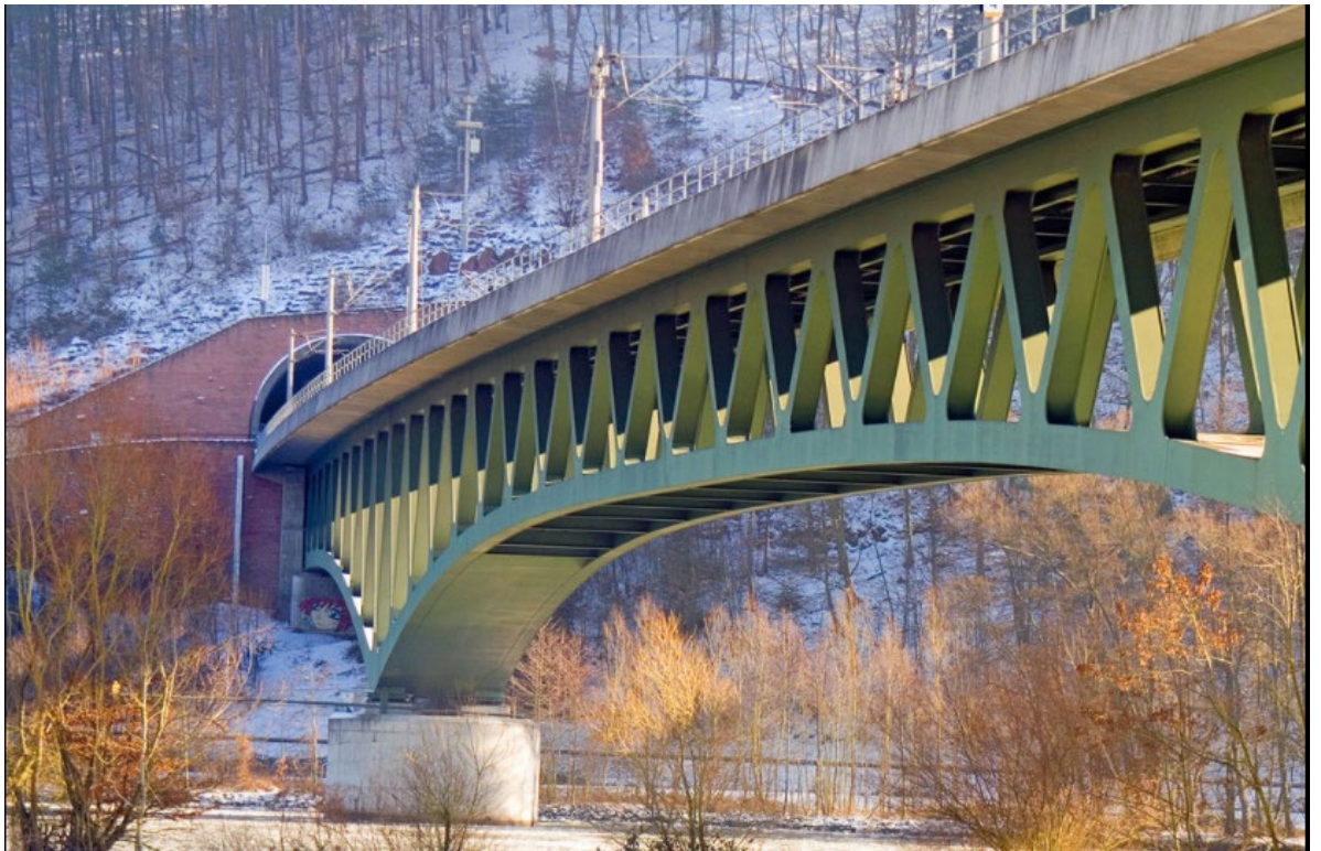
Рисунок 1.7 – Сталезалізобетонна ферма у місті Нантенбах (Nantenbach).
