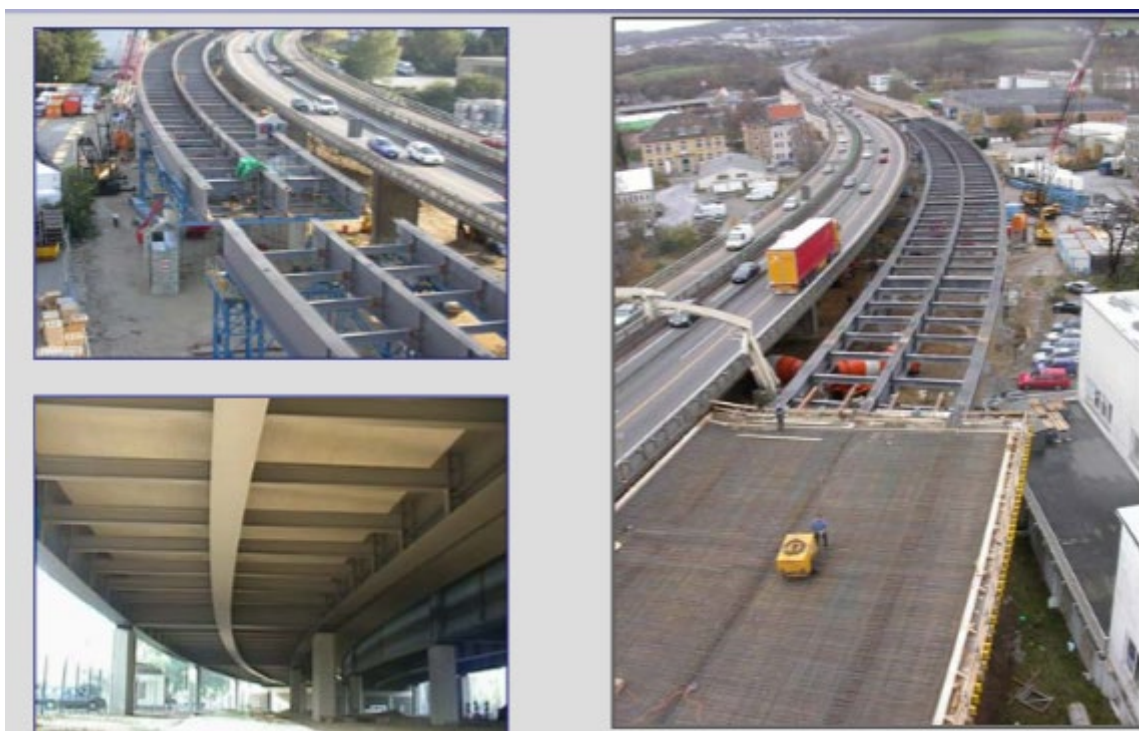
Рисунок 1.12– Зведення високошвидкісної автомагістралі у умовах щільної забудови. Гамбург.
