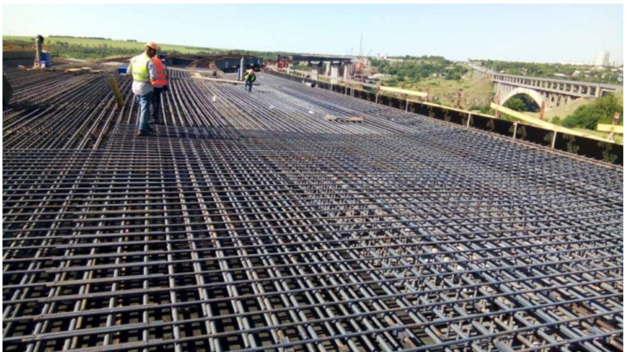
Рисунок 1.13– Зведення сталезалізобетонного мосту через річку Дніпро. Запоріжжя.
