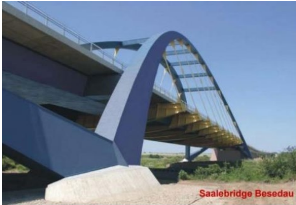
Рисунок 1.6 – Сталезалізобетонна арка з затяжною [1]
