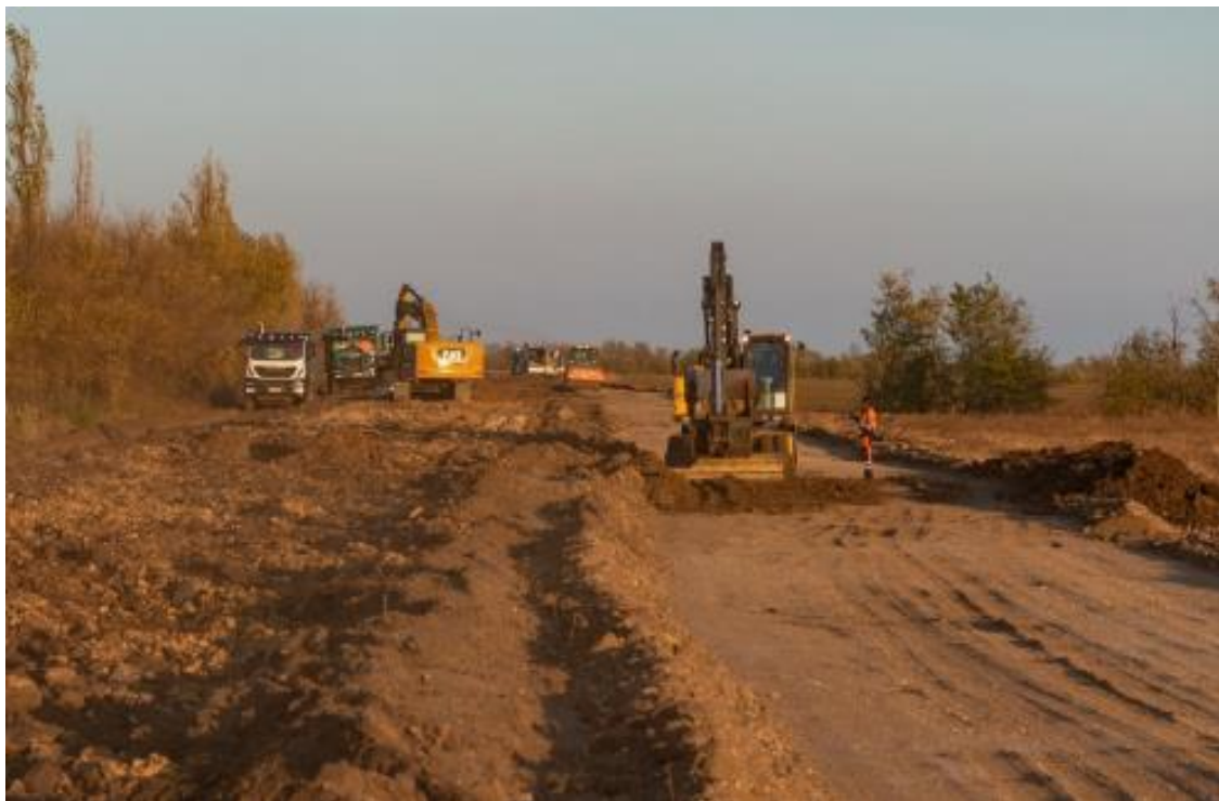
Рисунок 2.2 – Земляні роботи на трасі автомобільної дороги км 0+000 – км 11+000
