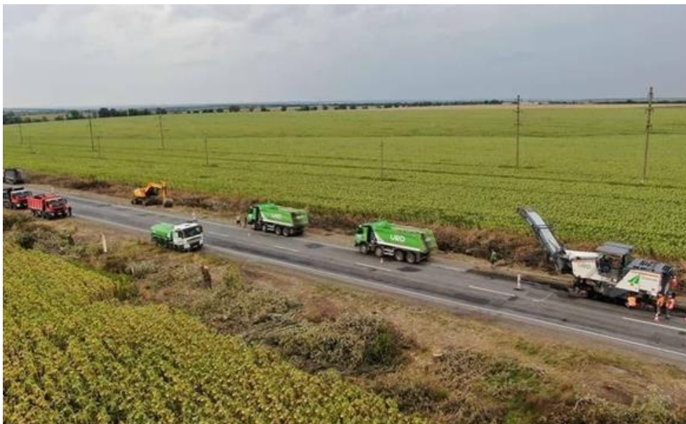
Рисунок 1.3 – Комплекс робіт з будівництва автодороги
