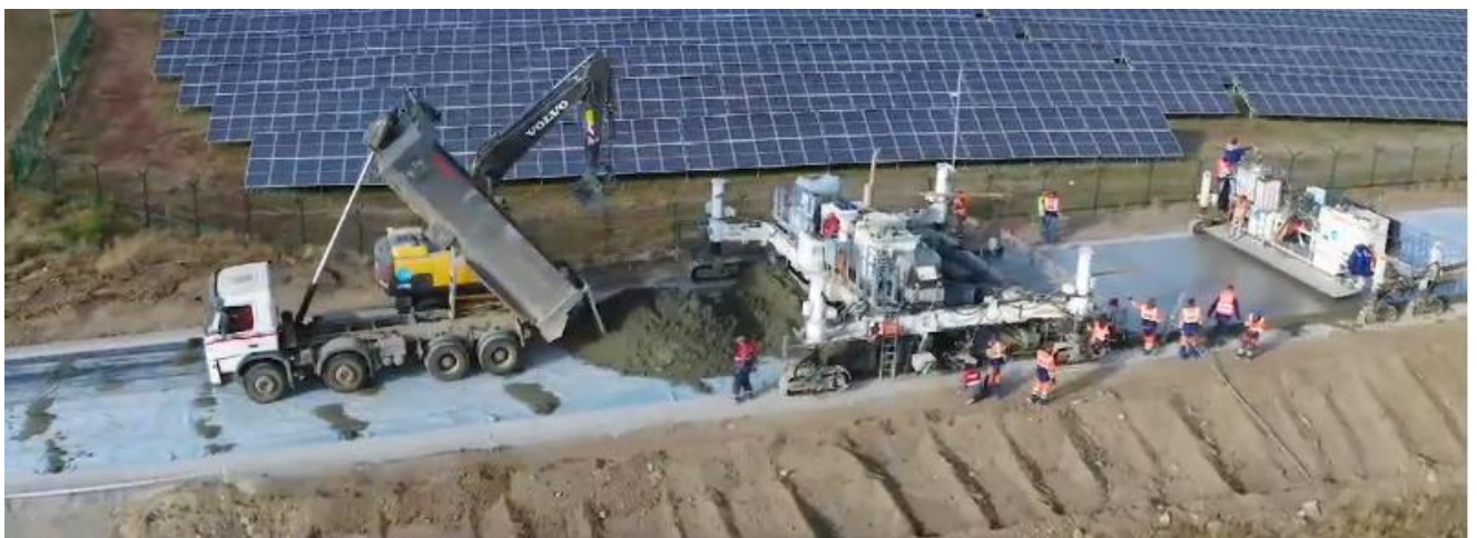
Рисунок 2.4 – Доставка цементобетону автосамоскидами
