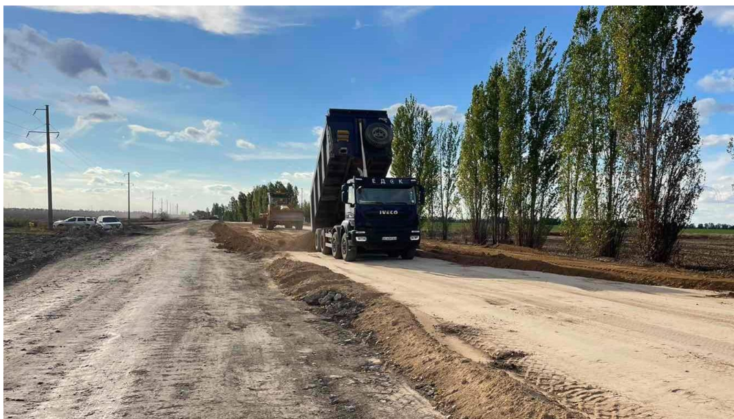
Рисунок 1.6 – Відновлення ділянки автодороги Миколаїв – Першотравневе
