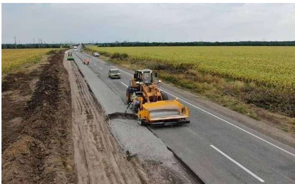
Рисунок 1.4 – Відновлення ділянки автодороги Благовіщенське – Миколаїв
