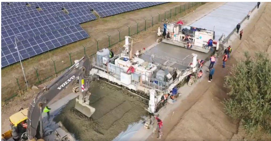
Рисунок 2.5 – Укладання цементобетону
