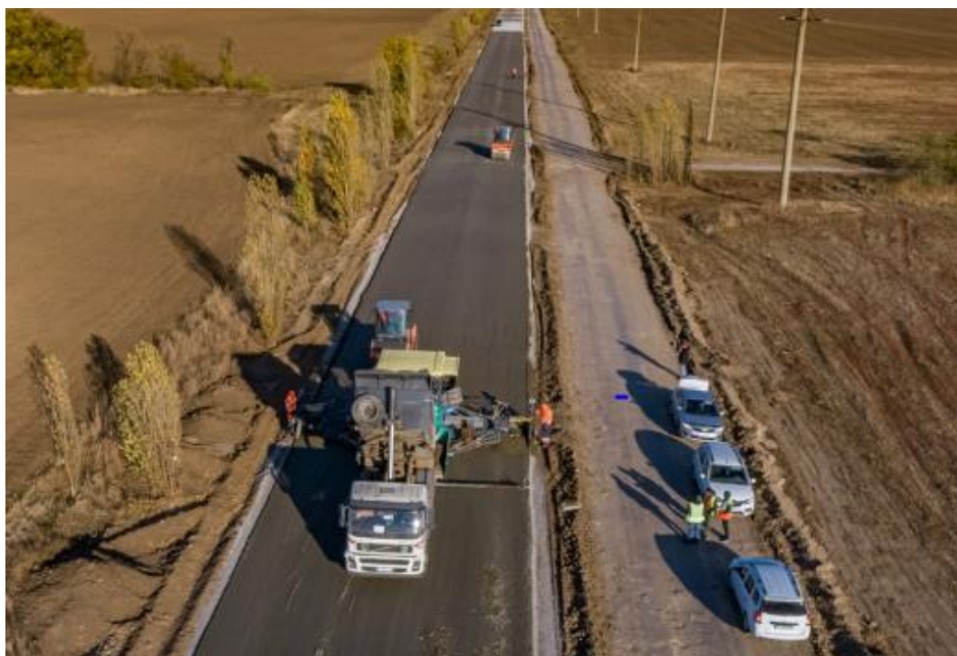
Рисунок 2.6 – Фрезерування покриття на всій протяжності автодороги
