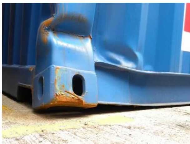
Рис. 1. Пошкодження контейнерів: a – зминання конструкції; б – деформація кутової стійки
