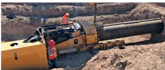
Рис. 1.7. Установки шнекового буріння: а) – розбурювання пілотного отвору – пресова бурова установка Perforator PVA-150 ; б) – розташування шнеку та ґрунту в момент пілотного розбурювання; в) – робота машини в напрямку з встановленою секцією труби, яка прокладається – пресова бурова установка Perforator PVA-200; г) – бурошнекова установка ABS-800 (Auger Boring Systems) (Германия)
