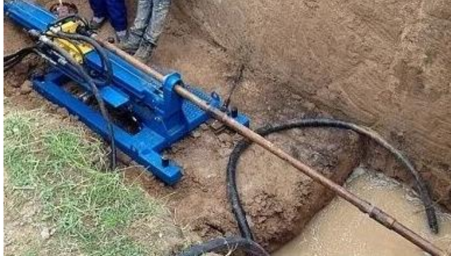
Рис. 1.6. Схема проколювання ґрунту з промиванням водою
