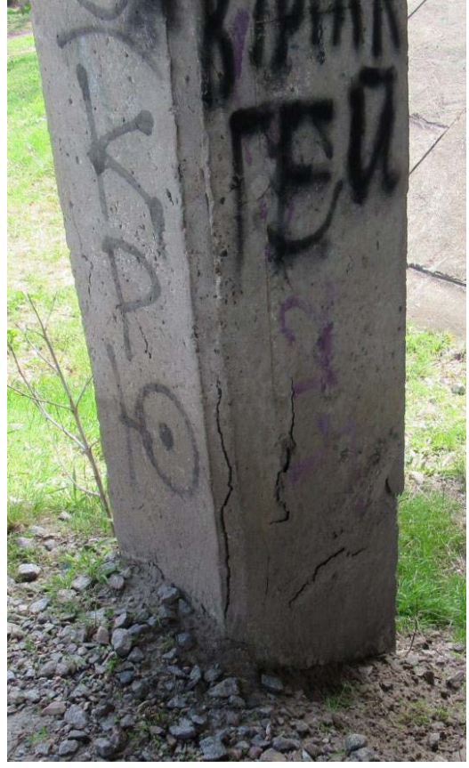
Рис. 2.6 Дефекти С1 проміжної опори №3
