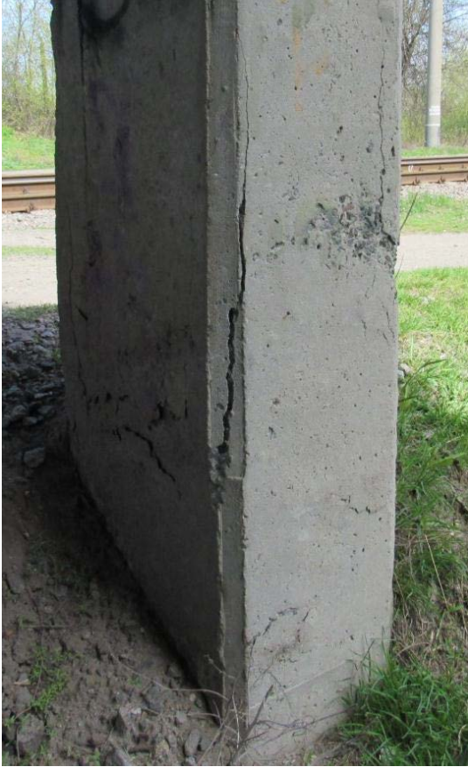
Рис. 2.6 Дефекти С1 проміжної опори №3
