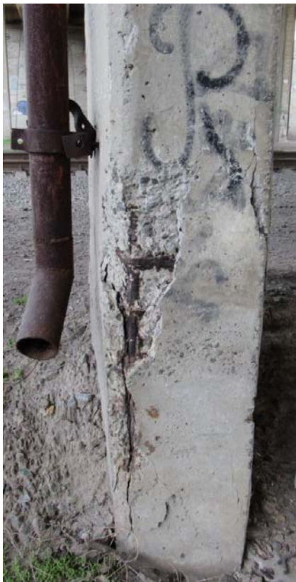
Рис. 2.7 Дефекти бетону на стійці С6 проміжної опори №3
