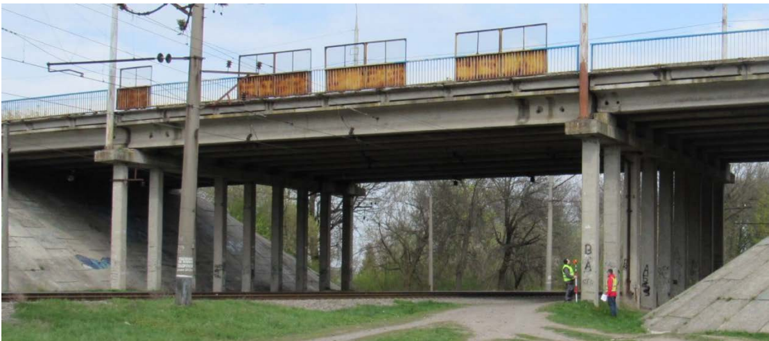
Рис. 1.4 Загальний вид підмостового простору
