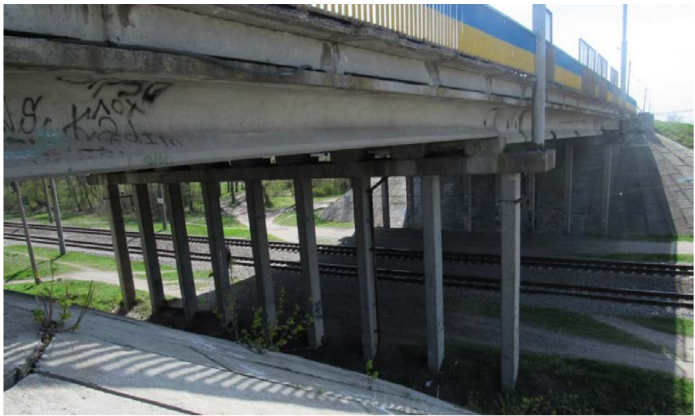
Рис. 1.2 Проміжна опора №2 шляхопроводу
