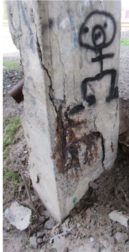
Рис. 2.7 Дефекти бетону на стійці С6 проміжної опори №3
