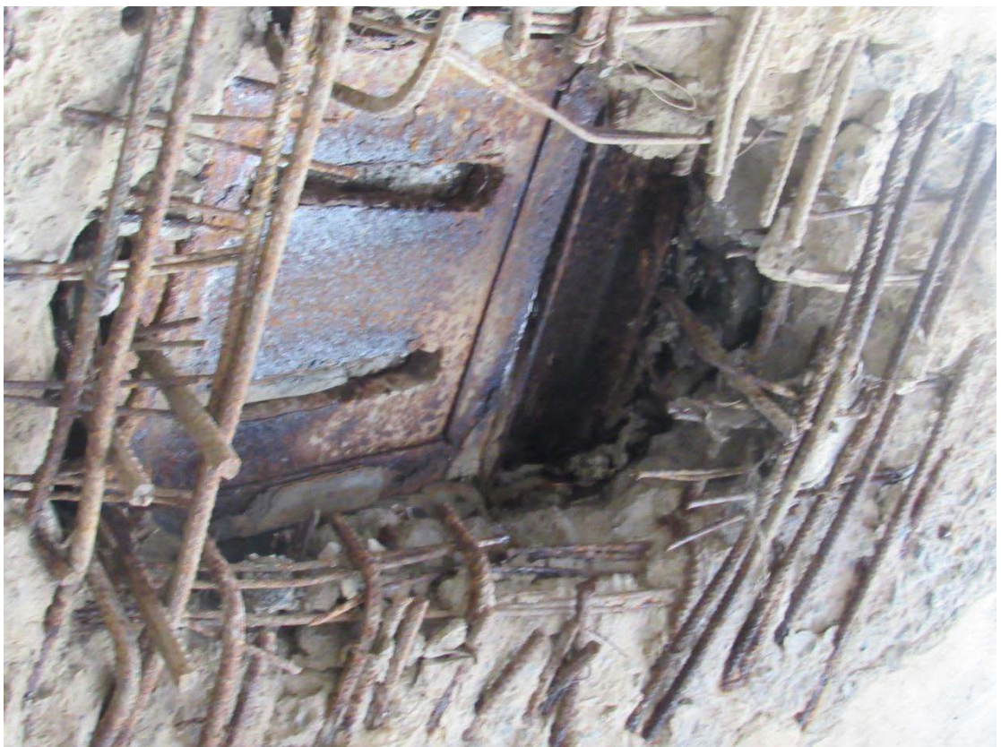
Рис. 2.4 Пролом плити прогонової будови ПБ 3-4
