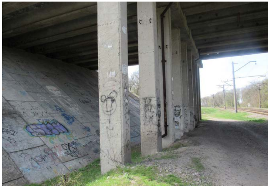
Рис 1.3 Проміжна опора №3 шляхопроводу
