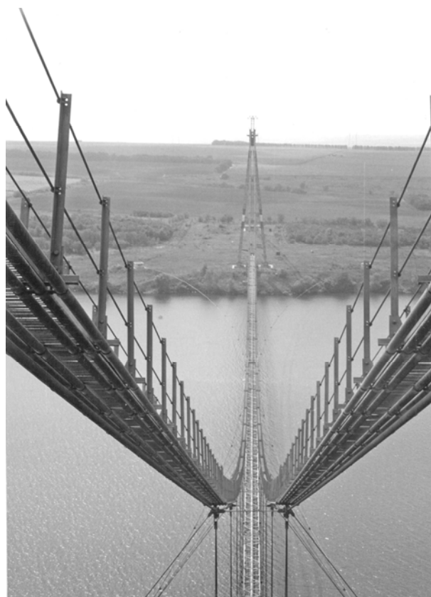
Рис. 2. Общий вид моста с пилона правого берега
