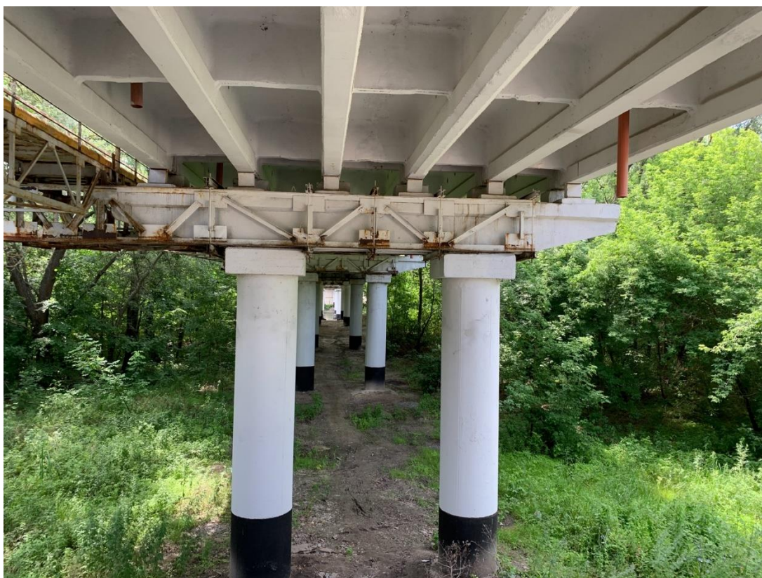
Рис. 1.4. Опора №2. Загальний вид (фото до проведення бойових дій, стан опори не змінився)
