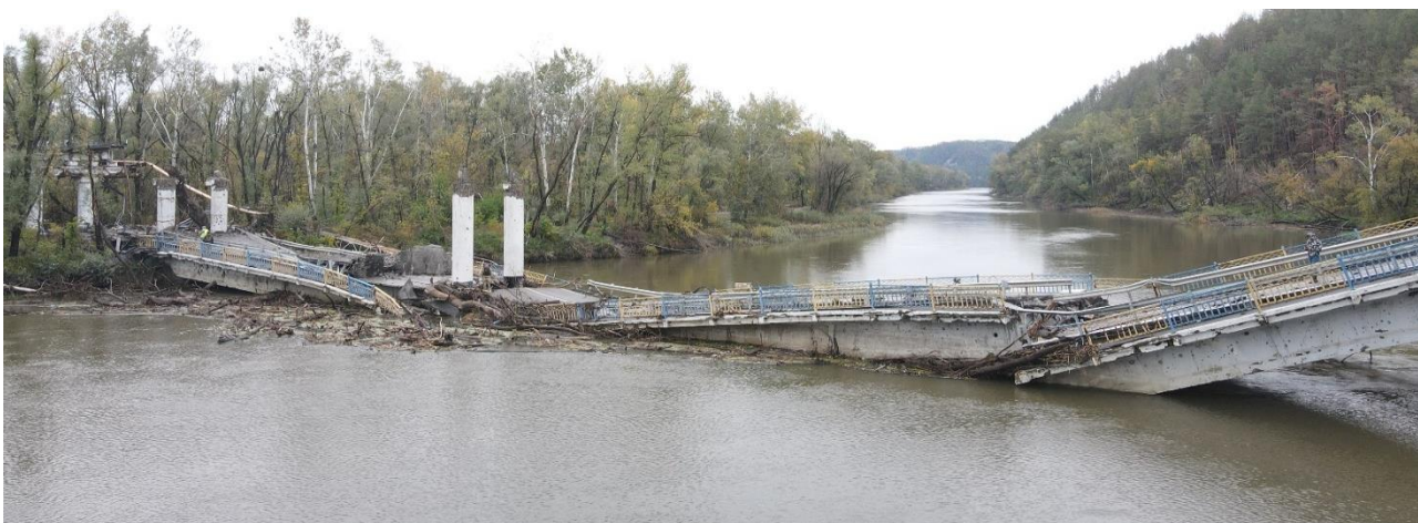
Рис. 1.1. Фрагмент загального виду мостового переходу
