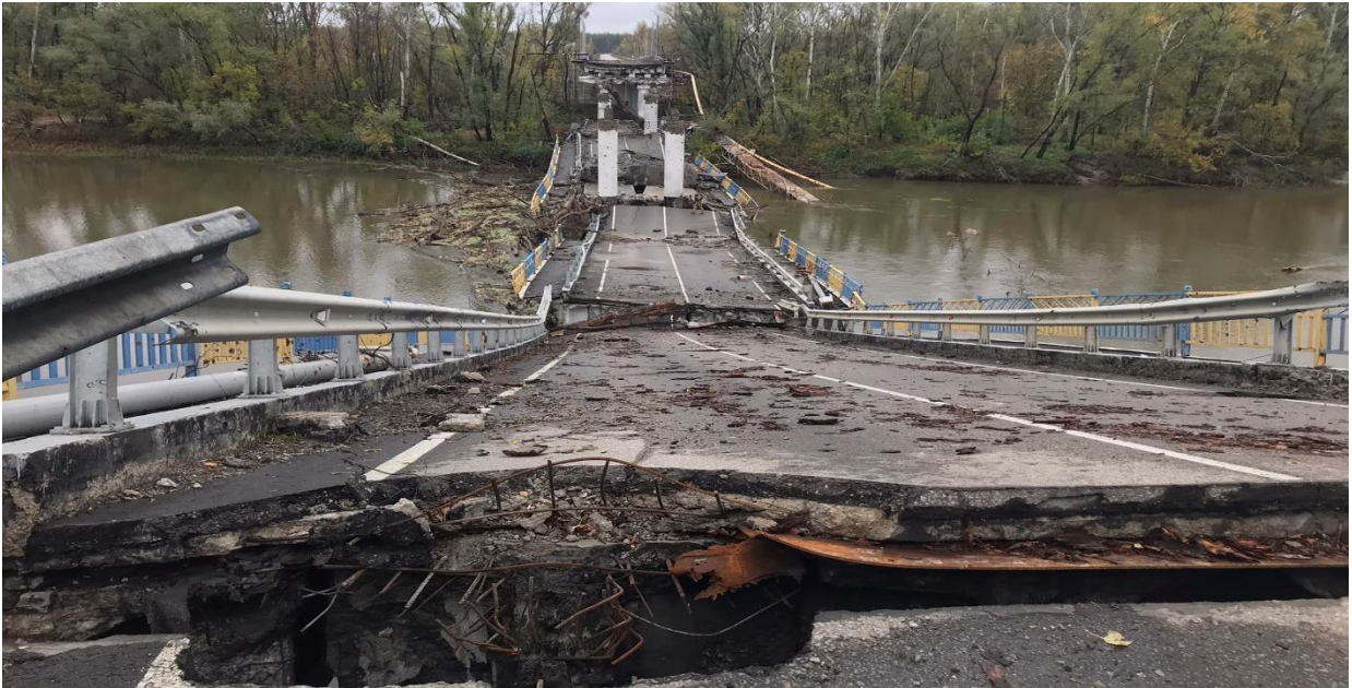
Рис. 1.2. Фрагмент загального виду мостового переходу
