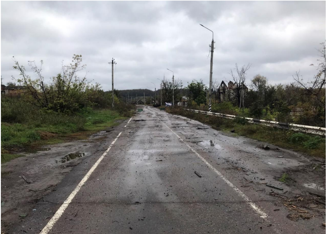
Рис. 1.11. Загальний вигляд підходів з боку ОПН№10 в бік М-03
