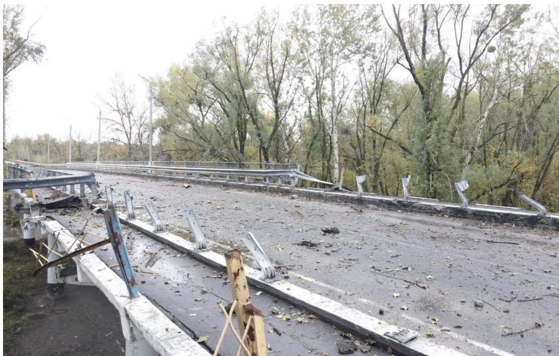
Рис. 1.9. Загальний вигляд проїзної частини мосту (збережена діляниця)
