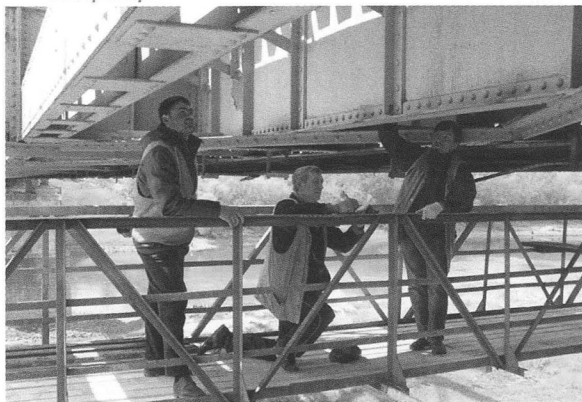
Обстеження прогонової будови співробітниками лабораторії
