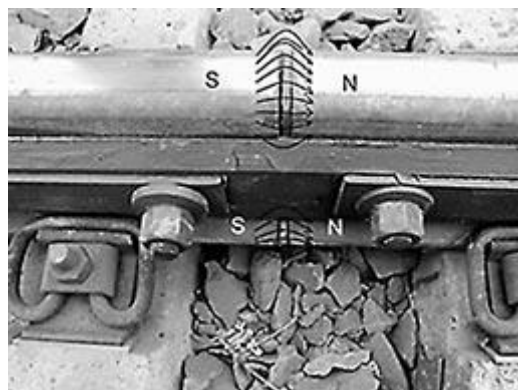
Рисунок 3.1 – Схема намагнічування рейок у районі стикового зазору
