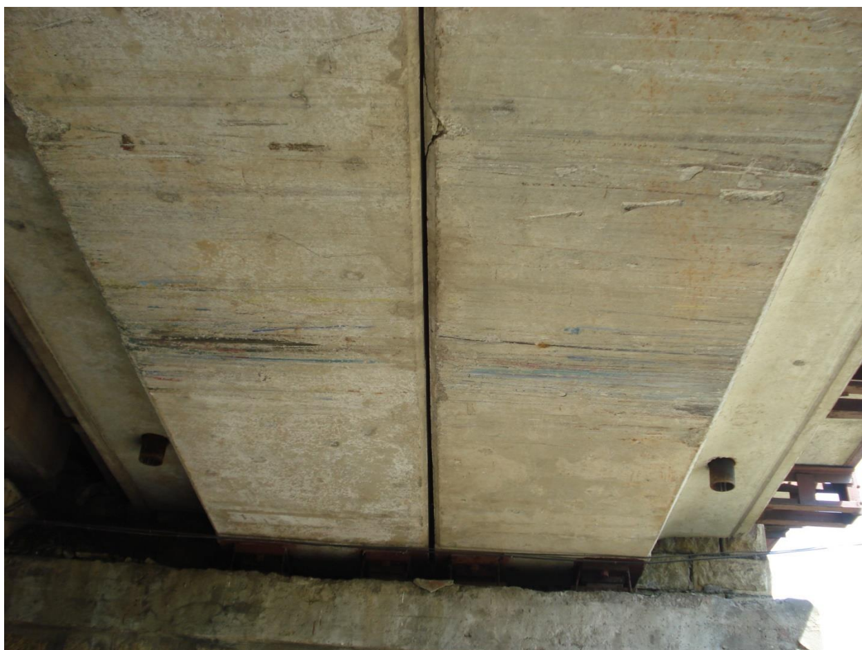
Рисунок – 1.6 Плитна залізобетонна прогонова будова L_p=13,60 м.
