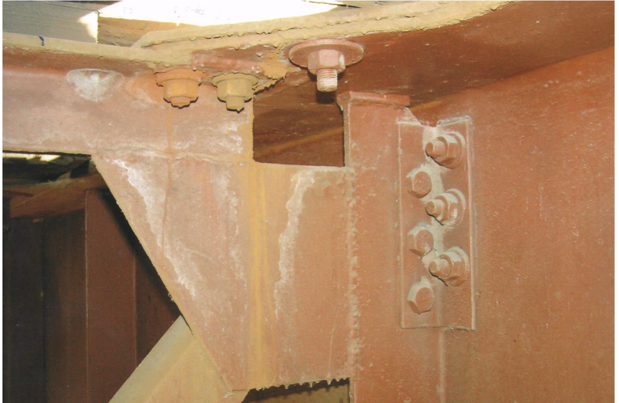
Рисунок 2.12 – Накладка на горизонтальній фасонці з виколами
