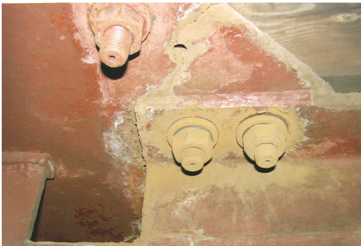
Рисунок 2.16 – Послабленні болти кріплення в'язів до фасонок
