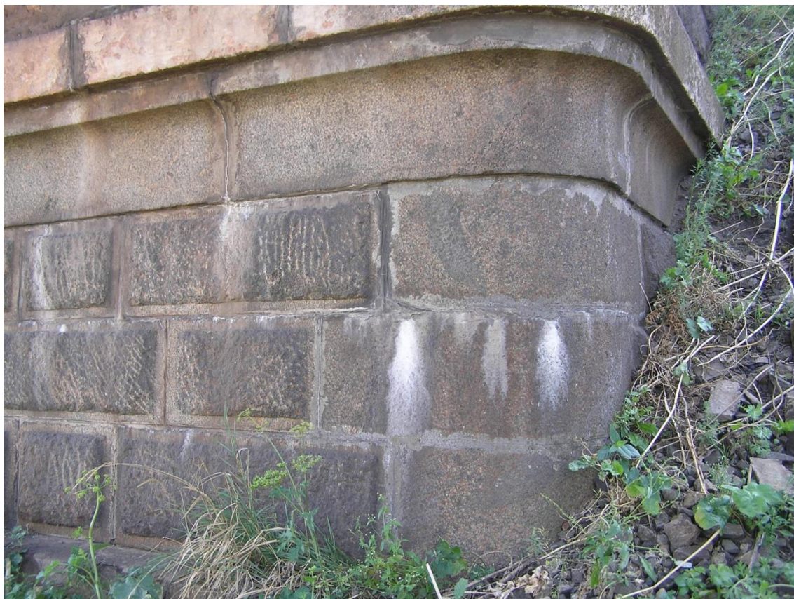
Рисунок – 2.1 Поверхня опори №1 з боку опори №2
