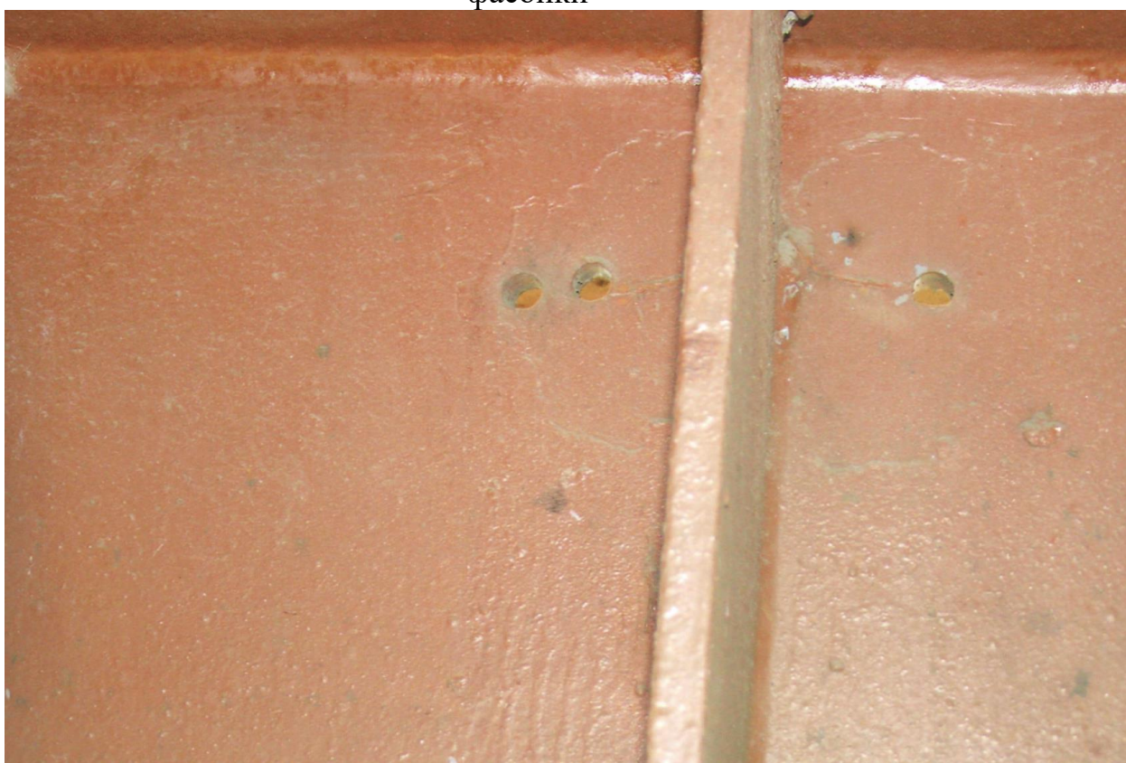
Рисунок 2.15 – Засвердлені кінці тріщини Т-9 в стінці головної балки, яка з'явилась біля верхніх кінців швів вертикального ребра жорсткості
