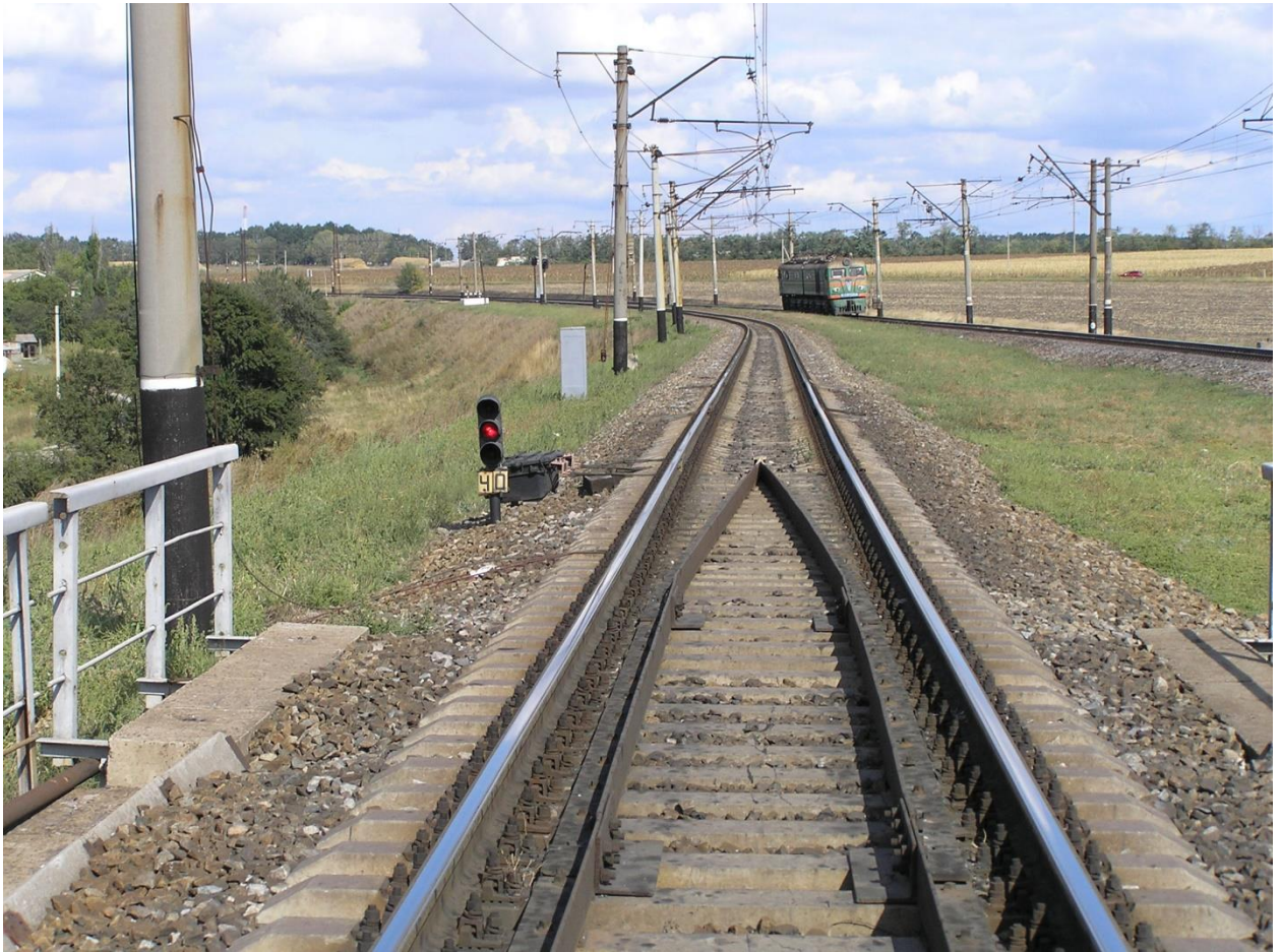
Рисунок – 2.9 Розташування контркутика на ділянці човника.
