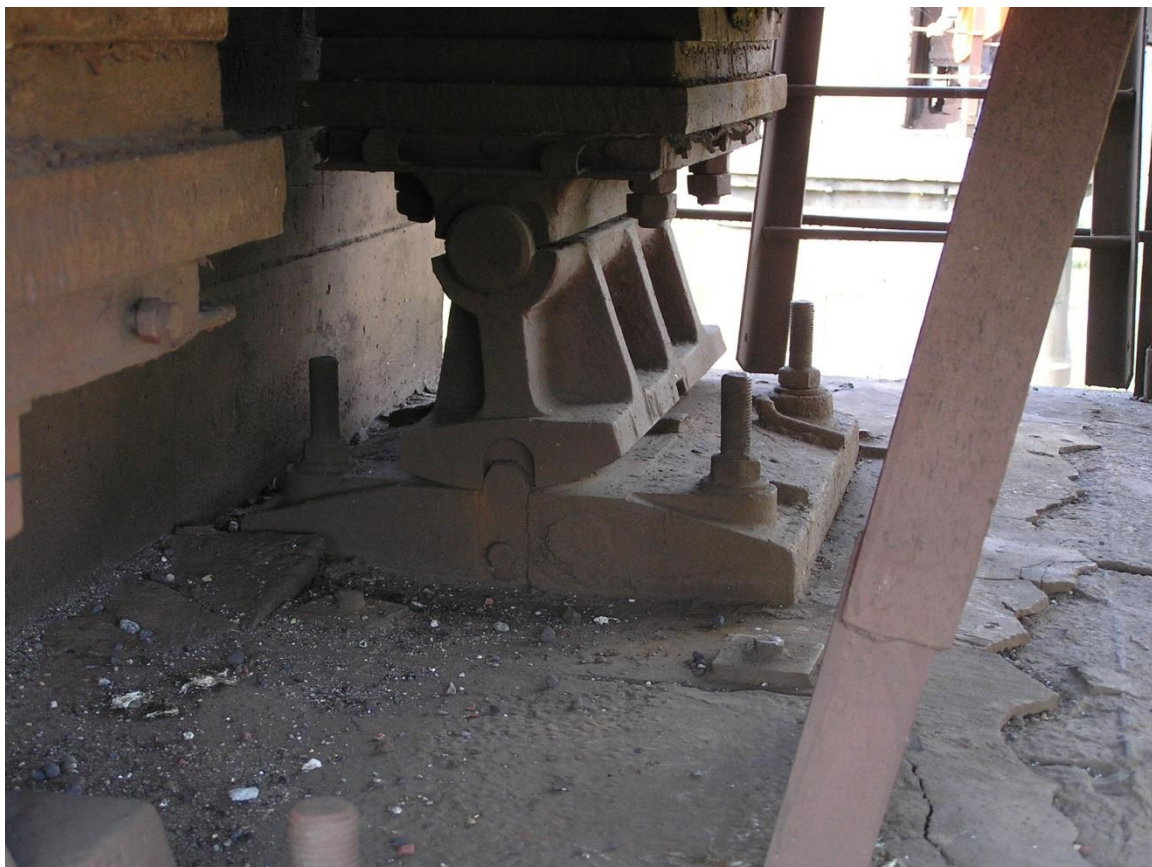
Рисунок – 2.5 Нахил секторів рухомої опорної частини у напрямку з прогону.
