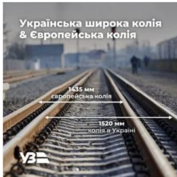
Рис. 3.3 – Суміщена колія 1520 і 1435 мм на залізобетонних шпалах
