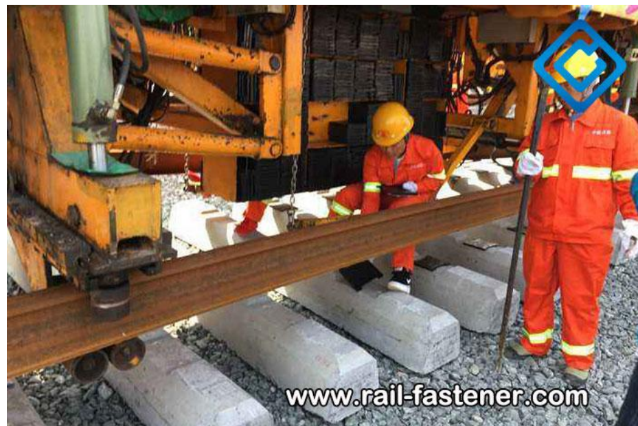
Рис. 2.2 Перевезення та укладання залізничних шпал
