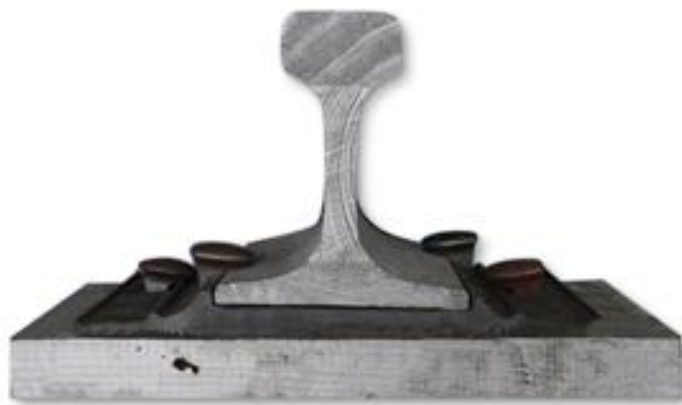
Рис. 2.6 Системи проміжного скріплення типу рейкових костилів
