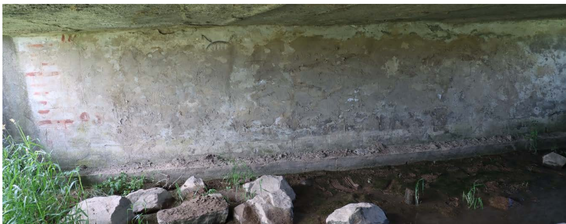
Рис. 2.9 Патьоки жовто-зеленого кольору та вилугування цементного каменю по кам'яній кладці та захисному цементному покритті стояна №1
