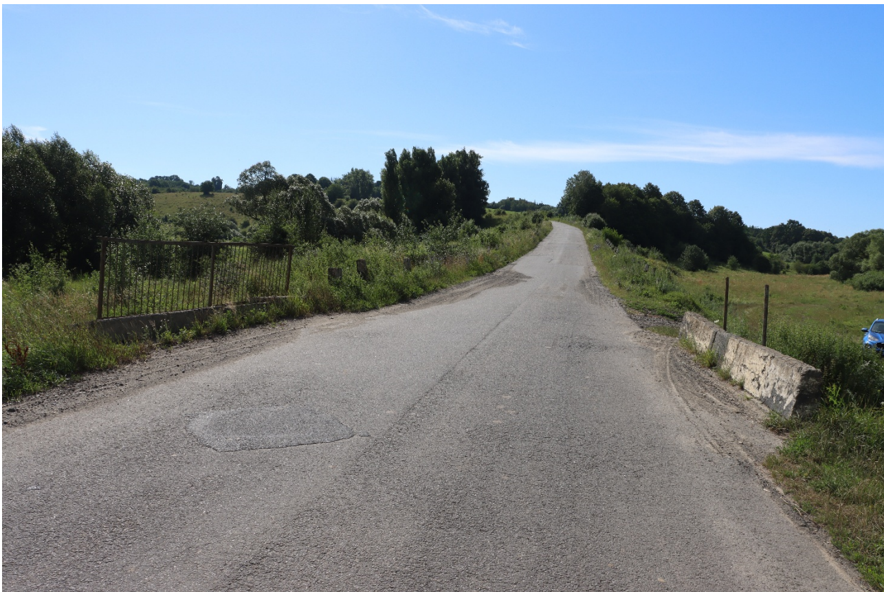
Рис. 1.6. Загальний вид на проїзну частину мосту
