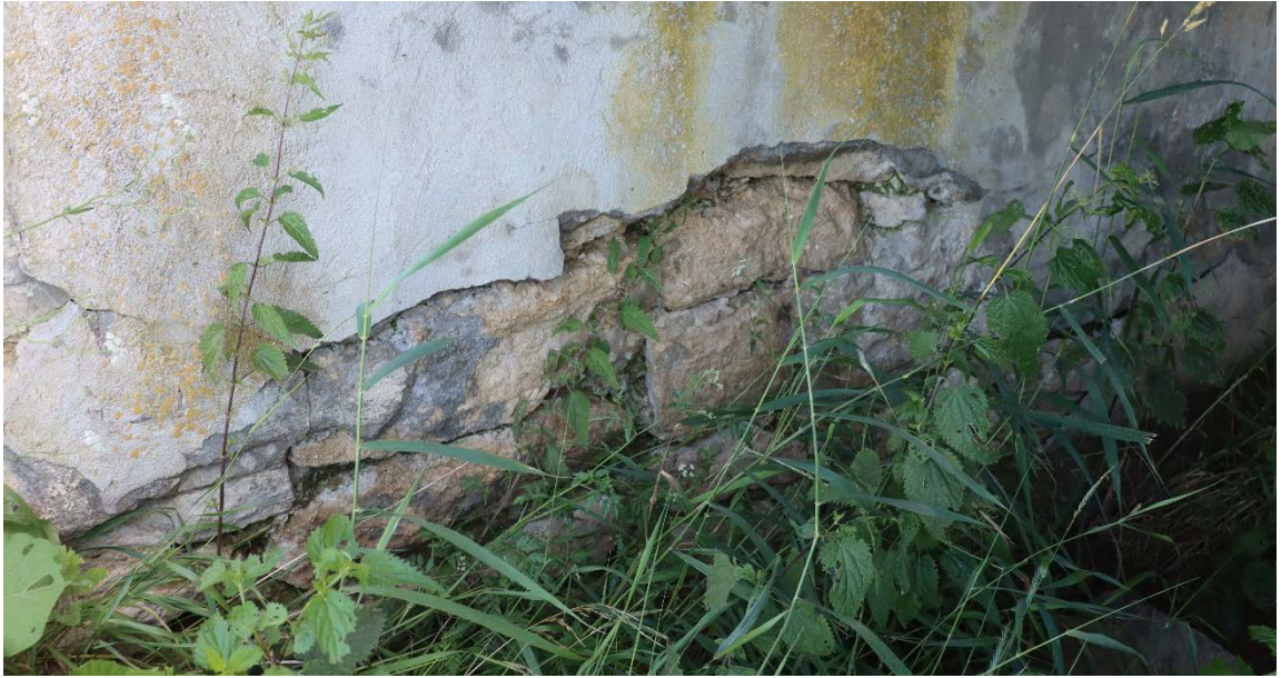
Рис. 2.6. Вивітрювання і вимивання цементного розчину з кам'яної кладки стояна №0
