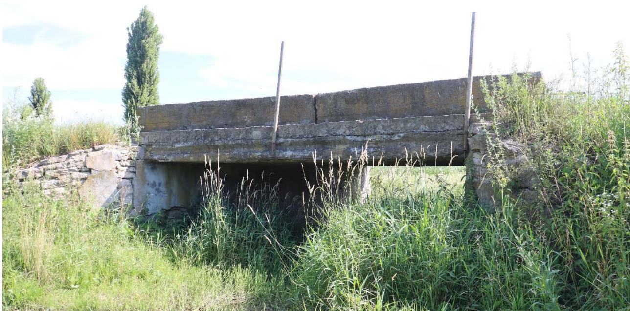
Рис. 1.1. Загальний вид мосту
