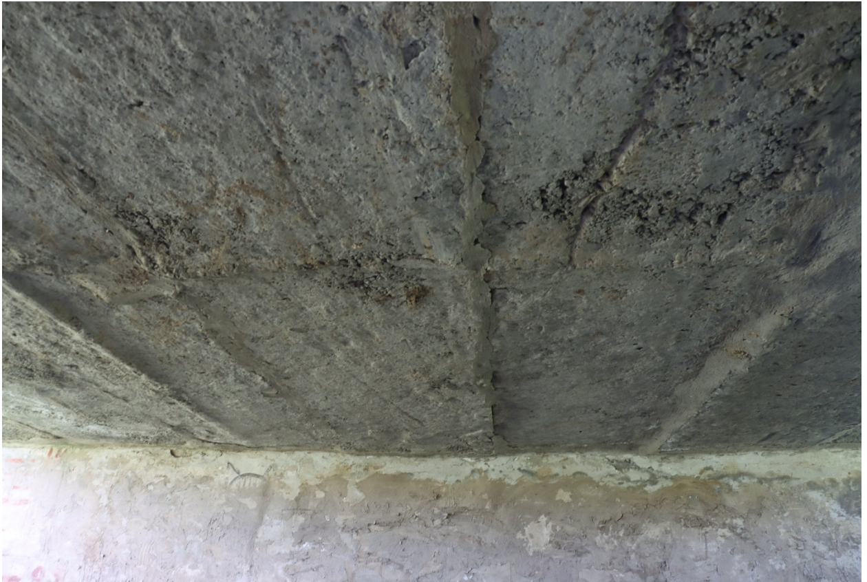
Рис. 1.3. Вид на прогонову будову 0-1 знизу
