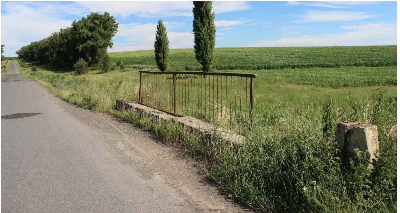
Рис. 1.7. Вид на тротуар, поручневе огородження автопроїзду.
