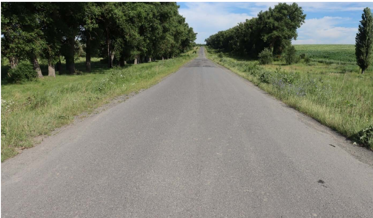
Рис. 1.8. Підхід до мосту зі сторони м. Деражня
