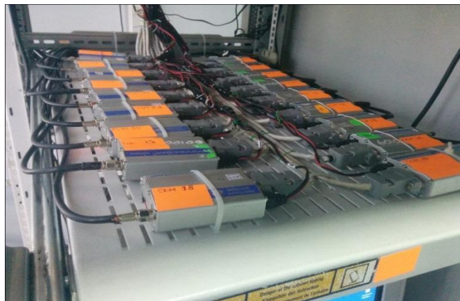
Рисунок 2.17 – GSM-модеми «Fastrack» M1206B встановленні у серверній стійці
