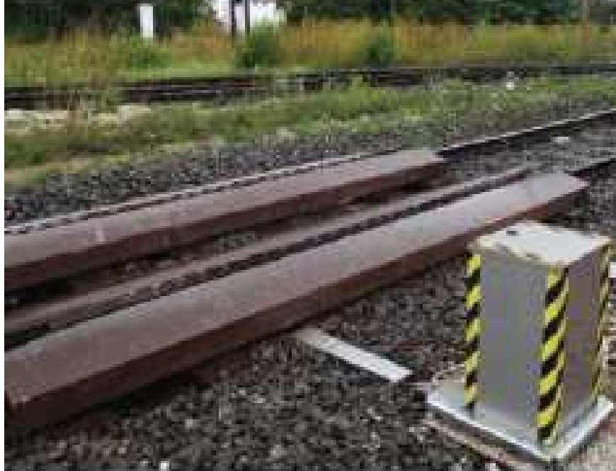
Рисунок 14 – Система змащування сповільнювачів на Нюрнберзькій гірці
