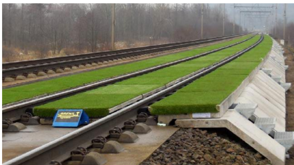
Рисунок 18 – Змонтований колійний абсорбер BRENS® із переробленого синтетичного матеріалу STERED® та штучною травою [44]
