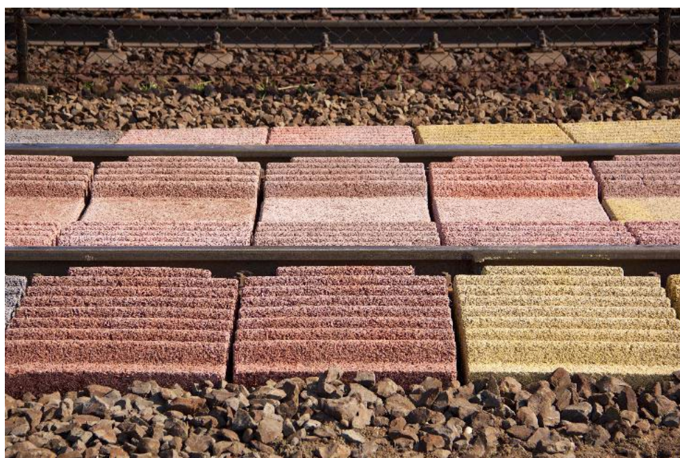
Рисунок 19 – Колійний шумопоглинаючий абсорбер Durisol із дерев'яно-цементних деталей [45]
