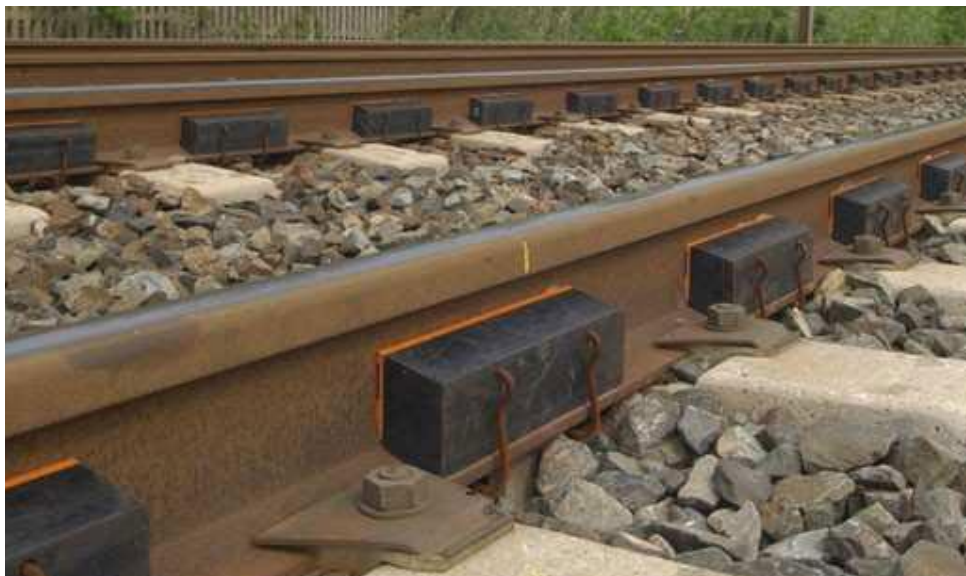
Рисунок 17 – Рейковий демпфер компанії Vossloh [6].
