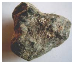
Рис. 6. Зразок щебеню в зруйнованому бетоні
