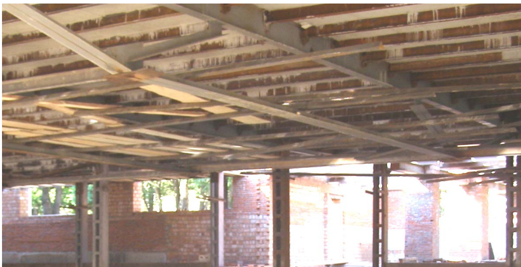
Рис. 5. Загальний вид балко-ферми перекриття в процесі будівництва L=18 м. м. Трускавець, санаторій «Женева», 2007 р.
