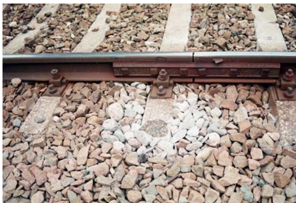
Рис. 6. Разбеливание цвета щебня в зоне некачественной подбивки шпалы
