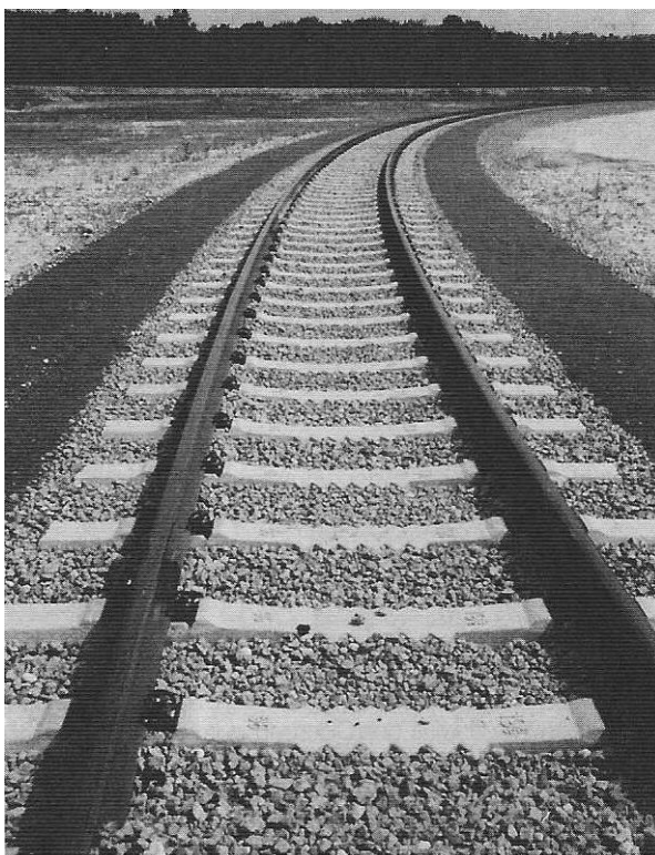
Рисунок 3.12 - Поздовжньо профільована шпала Ve19ae
