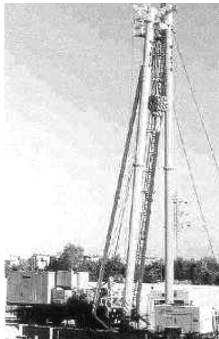
Рис. 1. Бурильная установка «WIRTH» L-35
