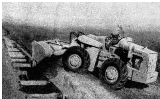
Рис. 4.12. Засипка ґрунтом траншеї
