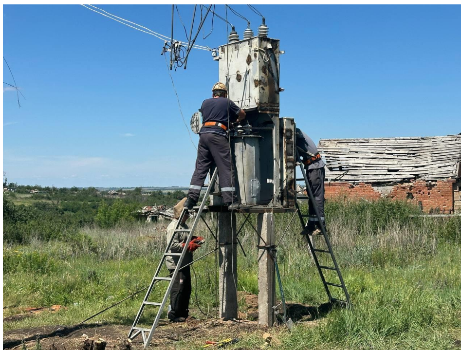
Рисунок 4.4 – Трансформатор 10/0,4 кВт
