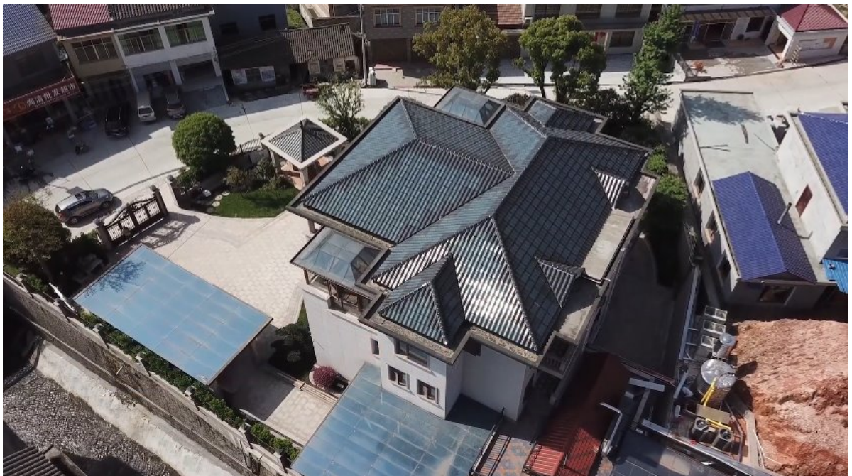
Рисунок 4.8 - Дім, облаштований фотоелектричною черепицею
