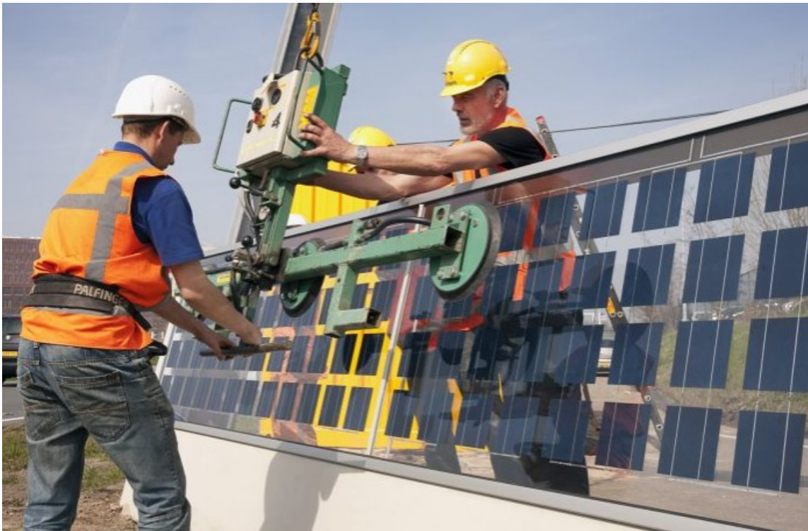
Рисунок 4.5 - Процес монтування звукових бар'єрів
