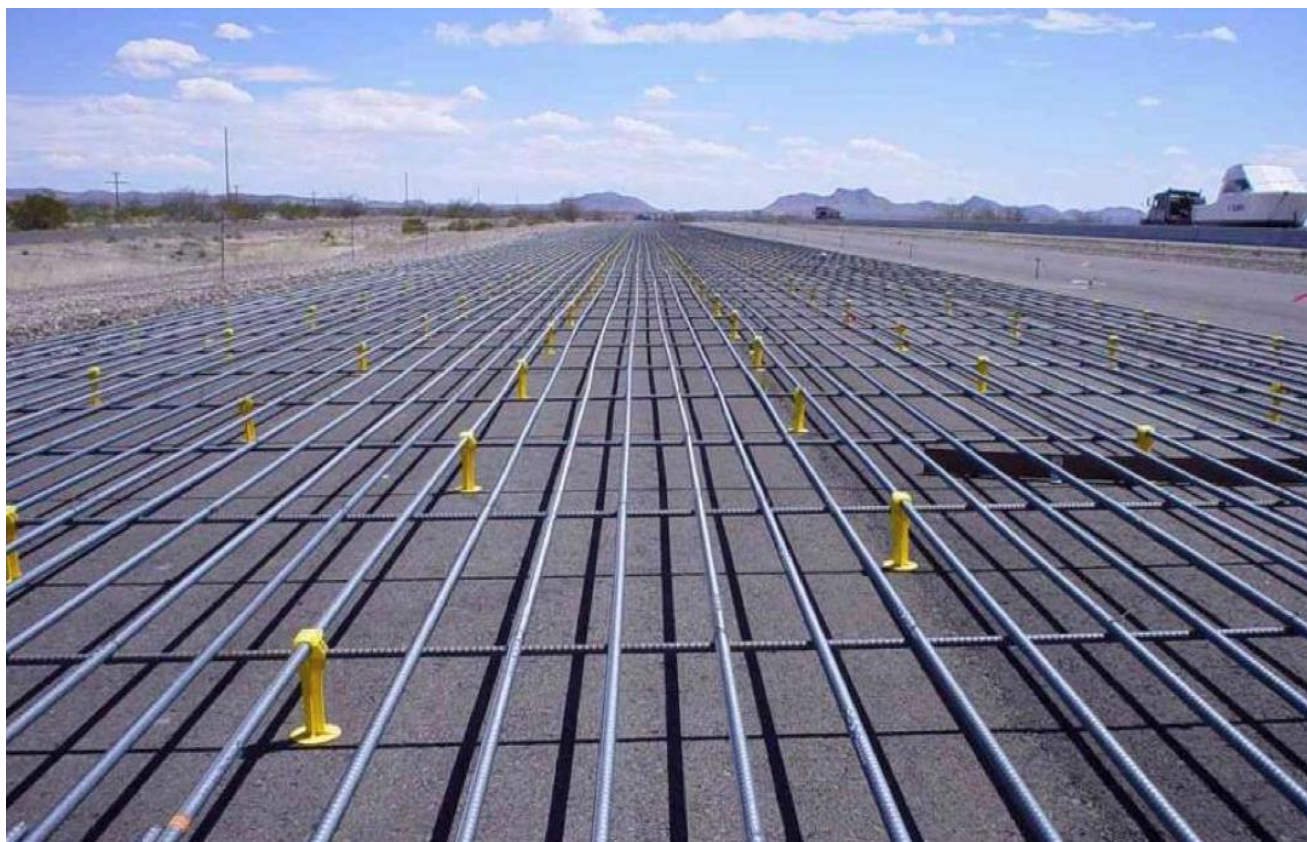
Рисунок 3.3 – Неметалева композитна арматура (CRCP) має ряд переваг перед сталевією
