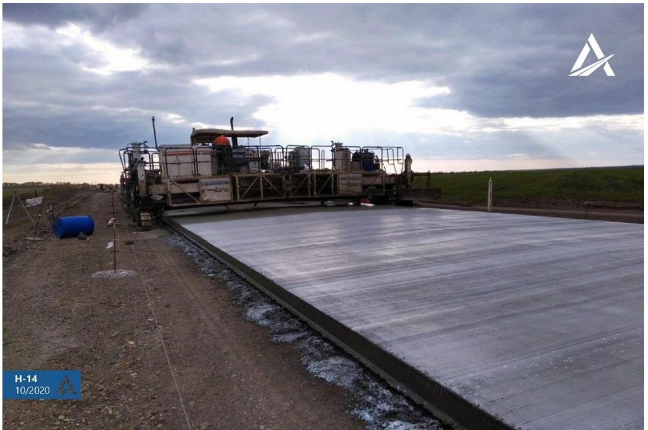
Рисунок 3.2 – Укладання фінішного шару важкого бетону на дорозі Н-14 Олександрівка — Кропивницький — Миколаїв.
