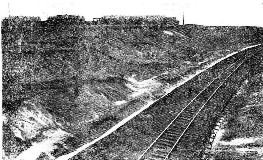
Фиг. 43. Наплывы белой, бурой и красной глины в нижней части откоса выемки Ясиноватая—Константиновка.
