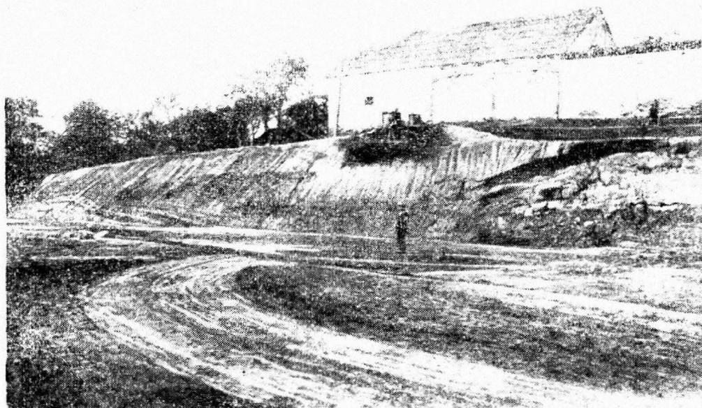
Фиг. 16. Сплыв откоса, вызвавший смещение основания стены каменного строения; ветка № 1--2 Витебского узла.
