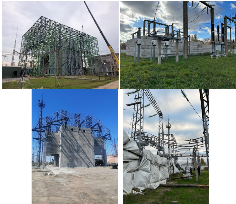
Рисунок 2 – Приклади влаштування захисту першого та другого рівнів
