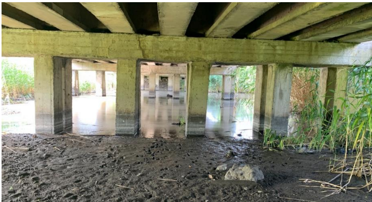
Рисунок 1.3 – Загальний вид опори №2
