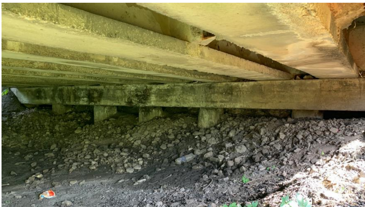
Рисунок 1.2 – Загальний вид опори №1
