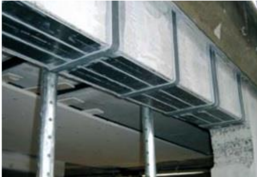
Рисунок 2.6 – Підсилення за похилим перерізом кутиками Sika CarboShear L
