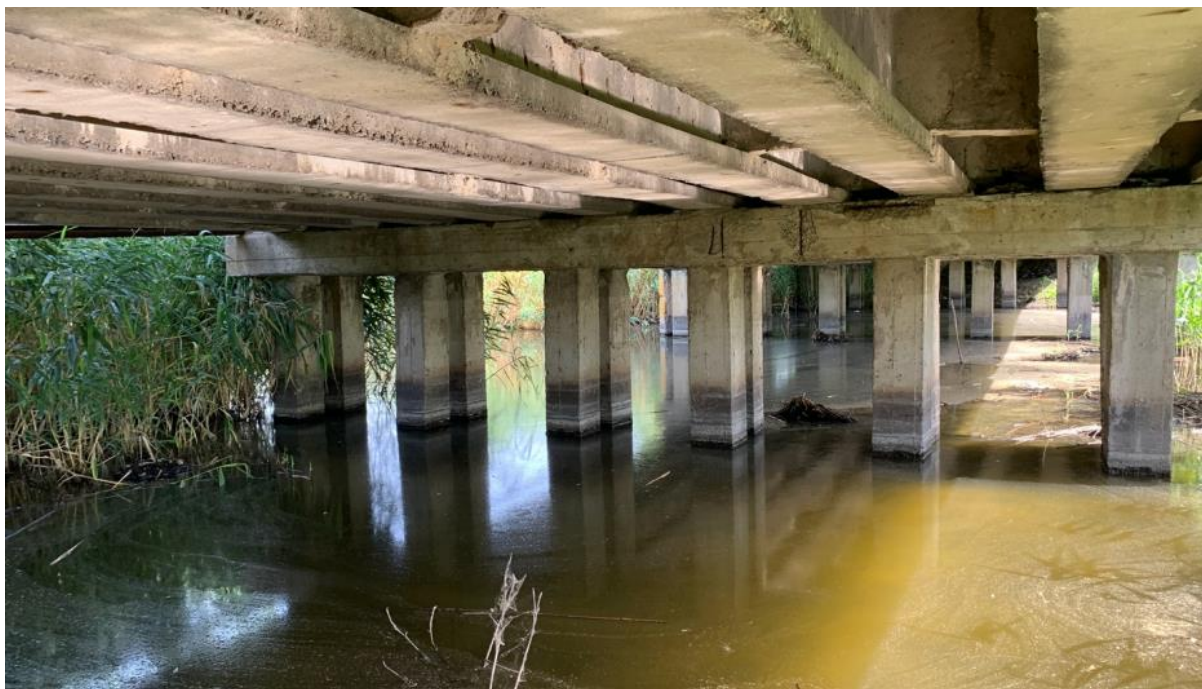
Рисунок 1.5 – Загальний вид опори №4
