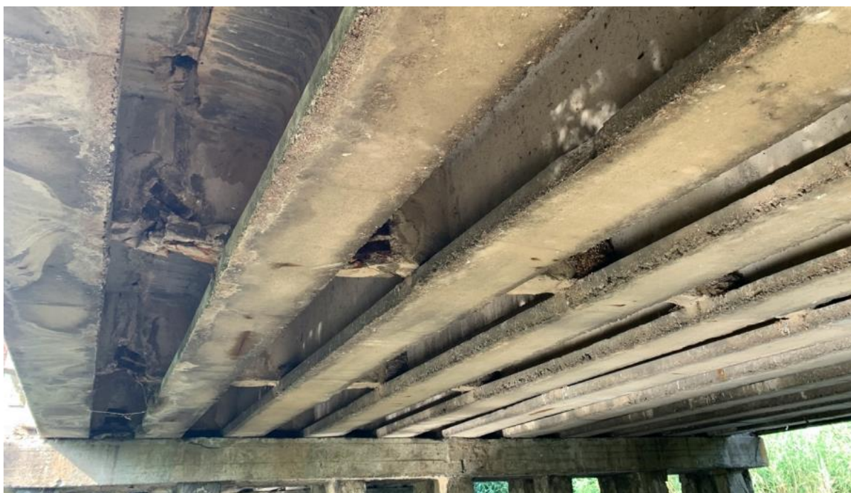
Рисунок 1.7 – Вид прогонової будови №2-3 та діафрагм із металевими накладками
