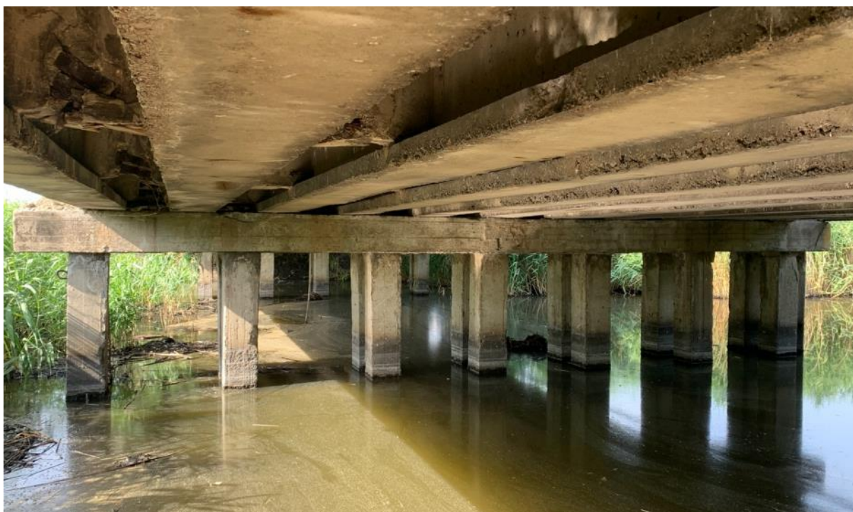
Рисунок 1.4 – Загальний вид опори №3
