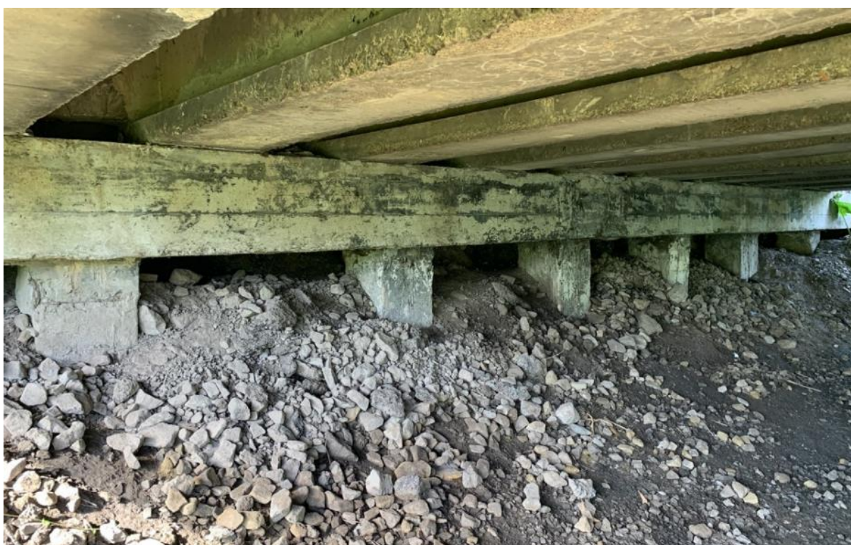
Рисунок 1.6 – Загальний вид опори №5
