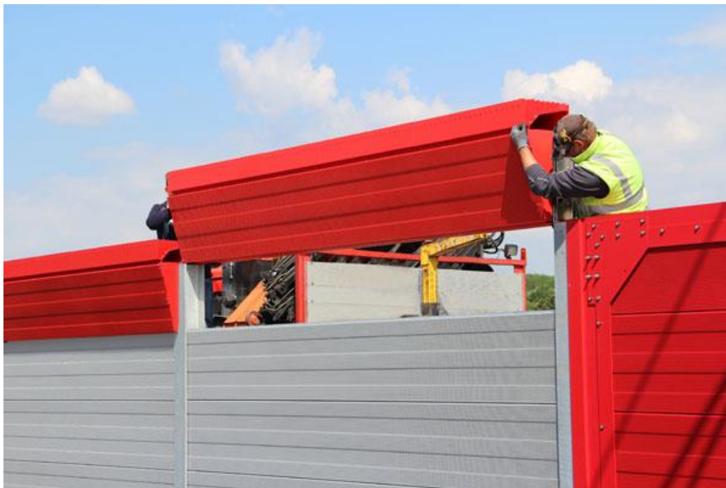
Рисунок 4.8 – Звуковий резонатор FONOCON із акустичним ковпачком для ефективного захисту від шумового навантаження [55]
