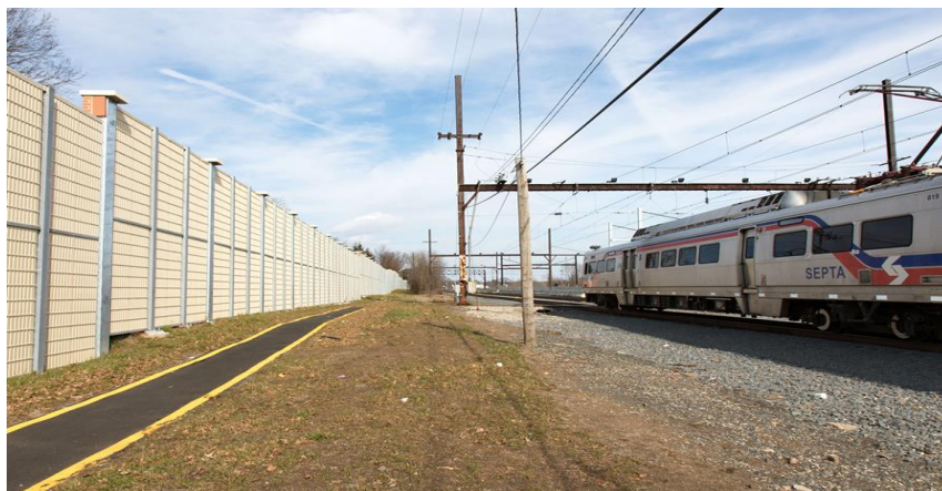
Рисунок 4.1 – Тип шумозахисного екрану для захисту прилеглої території від шумового навантаження пасажирських поїздів [54]
