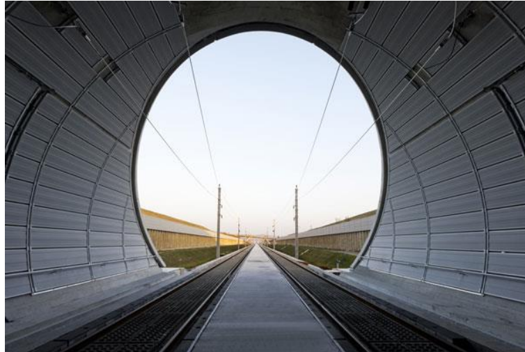
Рисунок 4.7 – Системи шумозахисту встановлені у тунелях [55]
