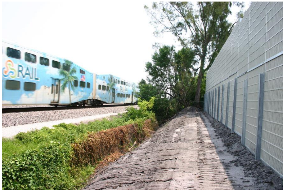
Рисунок 4.4 – Застосування шумозахисної стінки на залізничних коліях [54]
