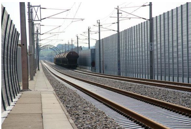
Рисунок 4.6 – Системи шумозахисту на залізничних станціях [55]
