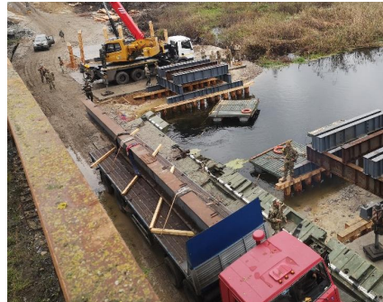
Рисунок 6 – Підготовка балки для встановлення в прогін
