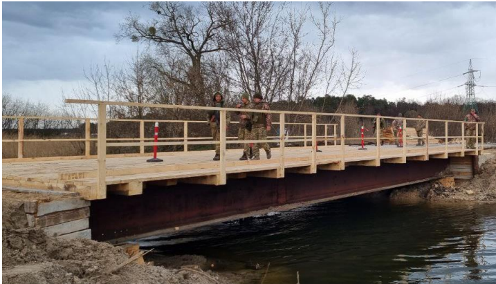
Рисунок 1 – Відновлення автомобільного мостового переходу через р. Ірпінь у с. Стоянка автомобільної дороги державного значення М-06 Київ-Чоп:
