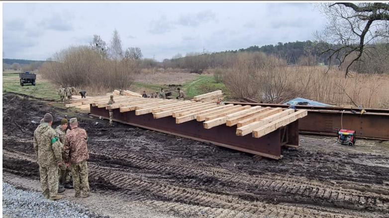
Рисунок 2 – Влаштування прогонової будови
