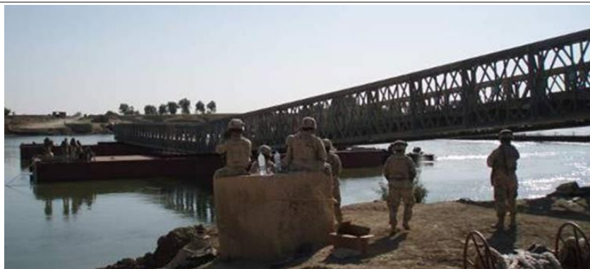
Рисунок 4 – Наплавний міст з майна мосту Бейлі та плашкоутів
