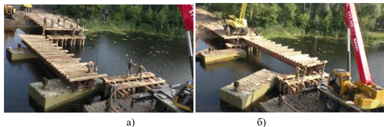
Рисунок 4 – Встановлення прогонової будови в прогін (а, б)
