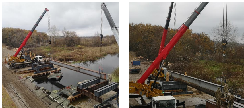
Рисунок 7 – Встановлення балок прогонових будов в прогін
