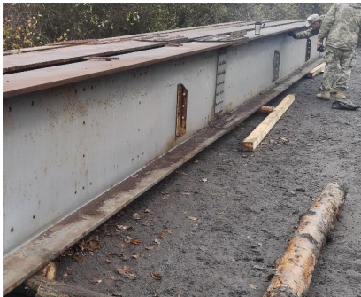
Рисунок 6 – Підготовка балки для встановлення в прогін
