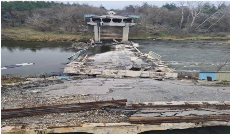
Рисунок 1 – Зруйнований міст через р. Сіверський Донець поблизу с. Червоний Шахтар
