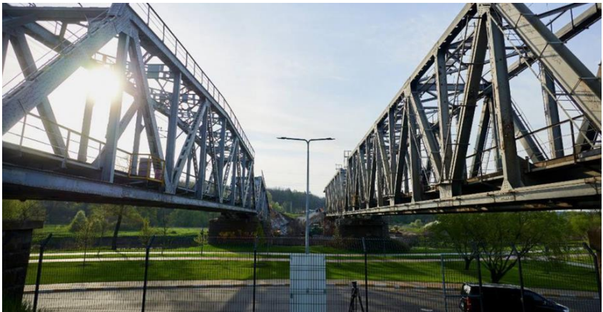
Рисунок 3 – Відновлення залізничного мостового переходу лінія Київ-Тетерів, перегін Біличі – Ірпінь: а) зруйнований міст; б) відновлений міст
