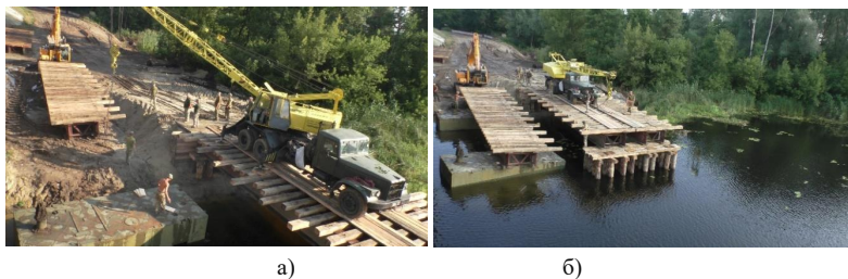
Рисунок 3 – Повздовжнє насування прогонової будови екскаватором (а, б)
