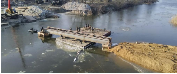
Рисунок 5 – Встановлення прогонової будови за допомогою плашкоуту
