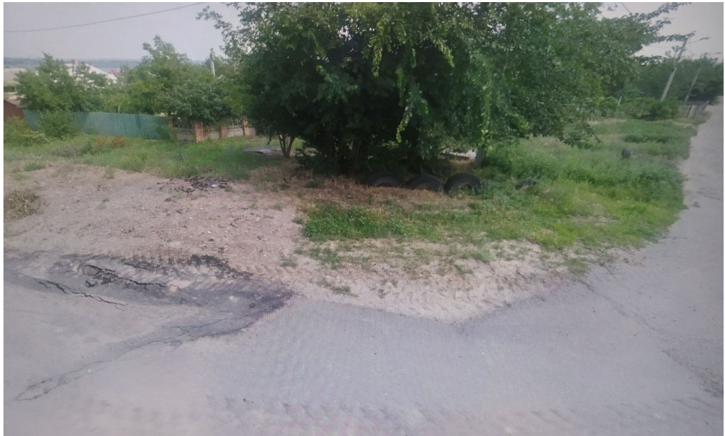
Рисунок 2.1 – Колійність з вибоїнами в асфальтобетонному покритті та несплановані узбіччя
