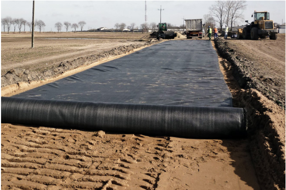
Рисунок 1.7 – Підсилення слабкої основи нового земляного полотна геосинтетичними матеріалами (геотекстильне полотно)
