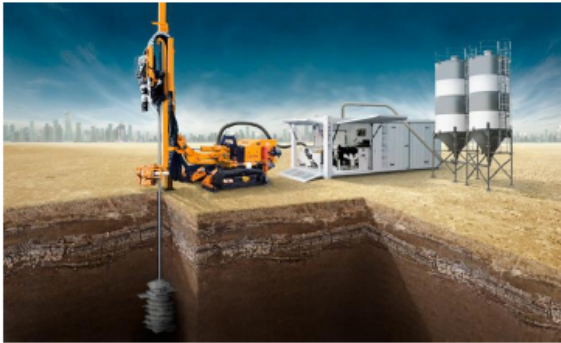
Рисунок 1.10 – Порядок робіт з підсилення земляного полотна за технологією Jet Grouting: а) встановлення бурової установки в робоче положення; б) буріння лідерної свердловини; в) підйом бурової штанги з одночасною подачею розчину через сопло монітору та перемішуванням ґрунту; г) створення ґрунтоцементної палі
