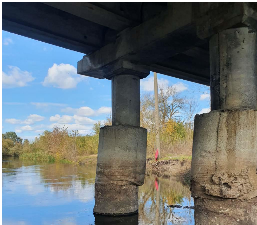
Рисунок 2.8 – Встановлення стійки опори на буровий стовп із ексцентриситетом (Стійка С1 опори Оп- 2).
