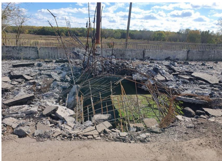
Рисунок 2.1 – Проїзна частина мосту. Наслідки вибуху в прогоні 4-5
