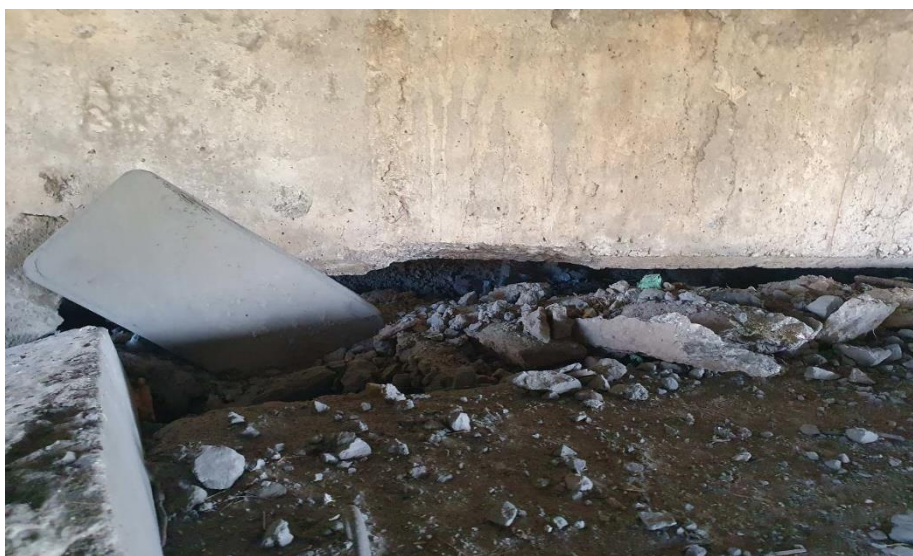
Рисунок 2.7 – Випадання опорних частин в результаті вибуху в прогоні 0-1
