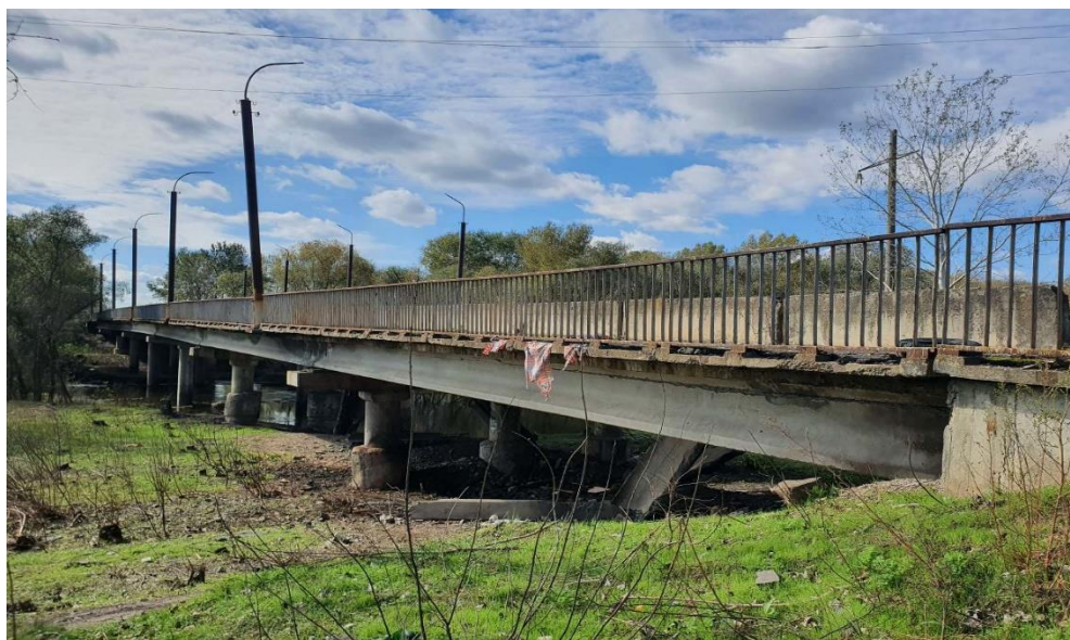
Рисунок 1.1 – Загальний вигляд ділянки мосту
