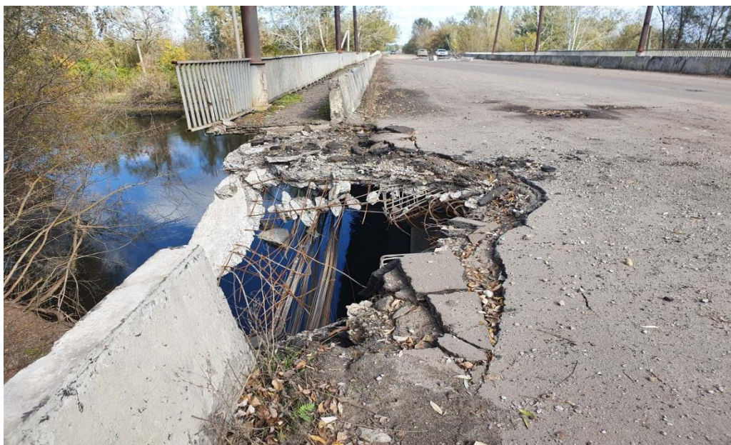
Рисунок 2.1 – Проїзна частина мосту. Наслідки вибуху в прогоні 4-5
