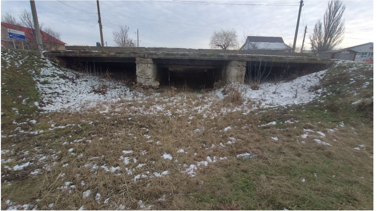
Рисунок 1.1 – Загальний вид мосту
