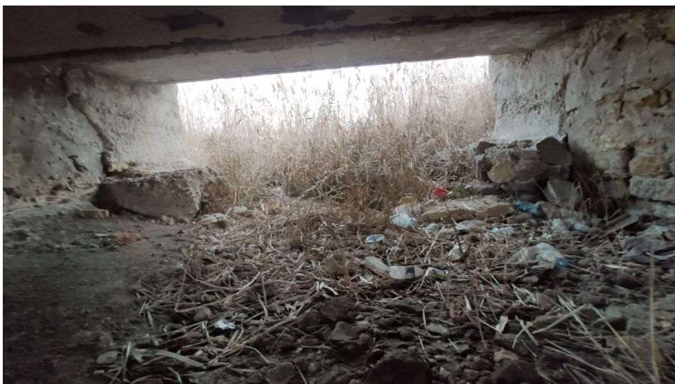
Рисунок 2.7 – Засміченість підмостової зони, наноси ґрунту.
