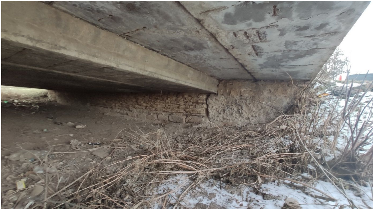
Рисунок 1.6 – Загальний вид проміжної опори №3
