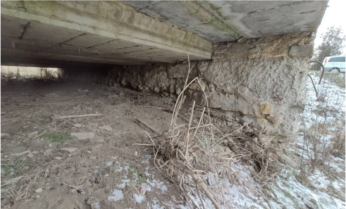
Рисунок 1.5 – Загальний вид проміжної опори № 1
