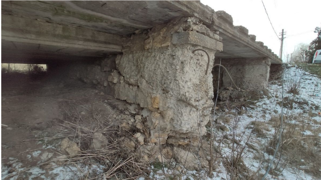
Рисунок 2.5 – Підмив опори №2
