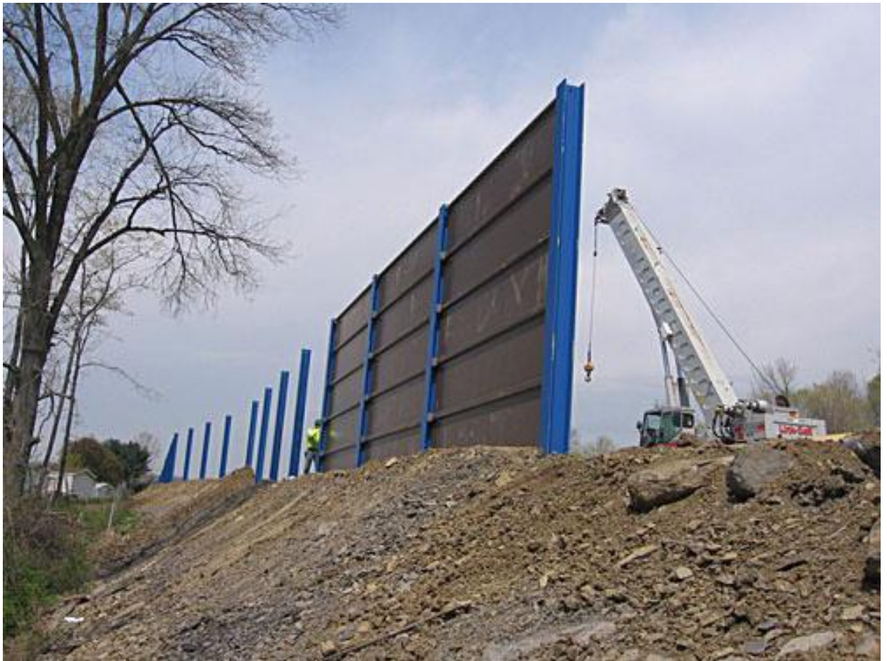
Рисунок 4.1 – Монтаж акустичних екранів
