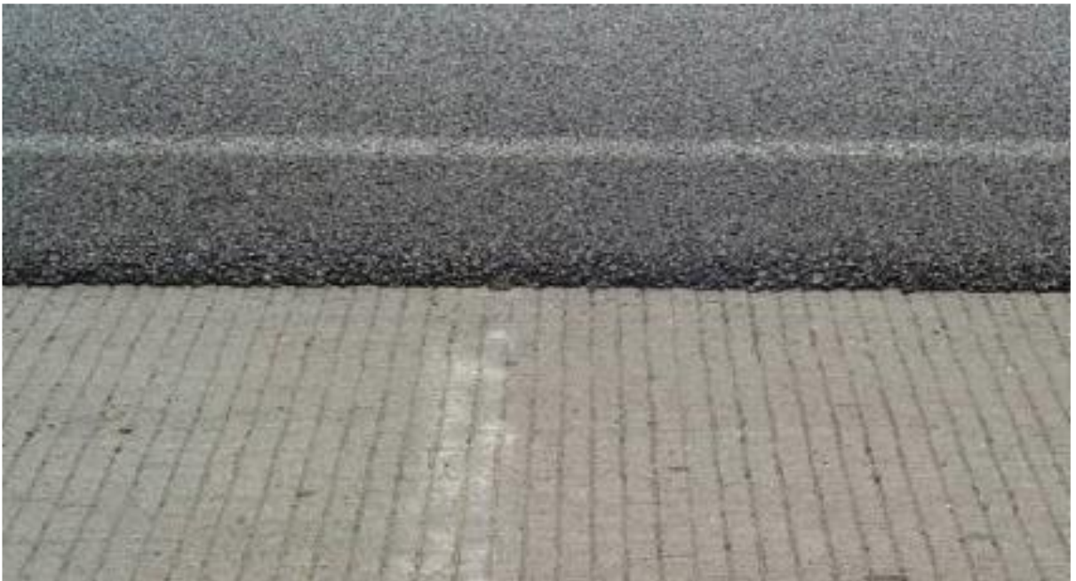
Рисунок 2.2 – Зображення готового «тихого» тротуару
