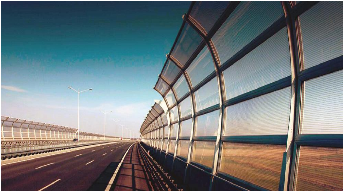
Рисунок 4.2 – Загальний вигляд шумозахисних екранів
