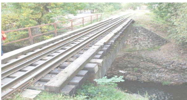
Рис. 11. Загальний вигляд мостового полотна
