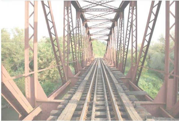
Рис. 4. Загальний вигляд мостового полотна
