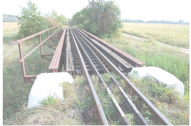
Рис. 6. Загальний вигляд мостового полотна на ПК 183+94,1.
