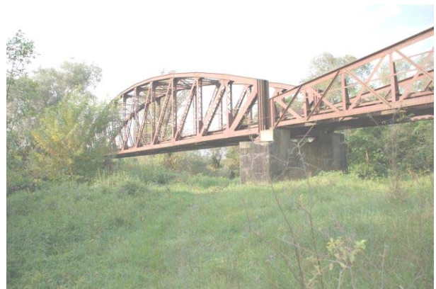
Рис. 3. Загальний вигляд мосту на ПК 191+1,4
