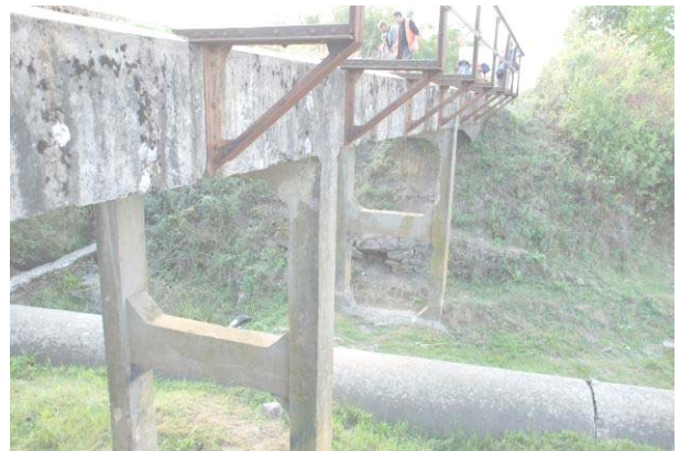
Рис. 7. Загальний вигляд мосту на ПК 86+04,5.
