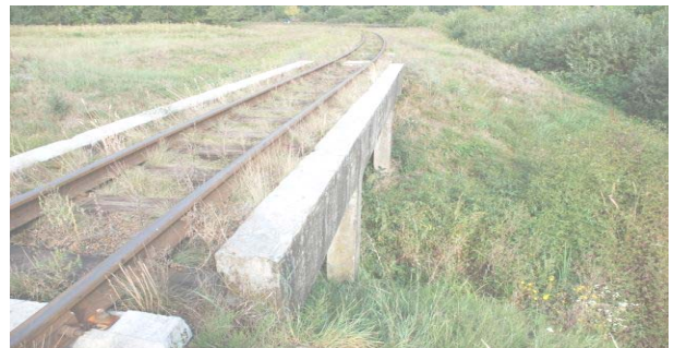
Рис. 8. Загальний вигляд мостового полотна
