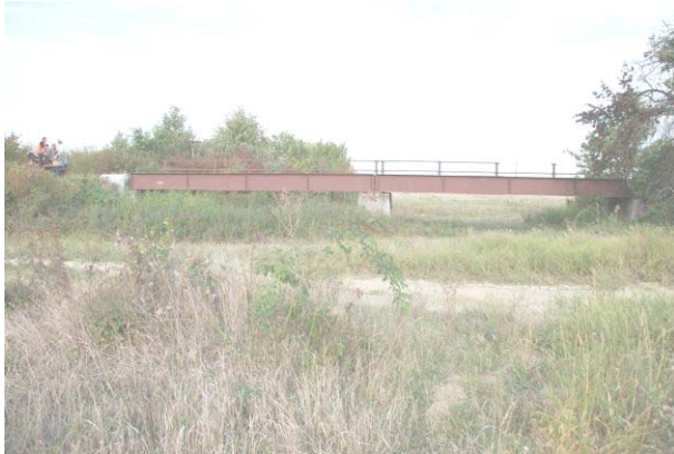
Рис. 5. Загальний вигляд мосту на ПК 183+94,1
