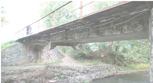
Рис. 10. Загальний вигляд мосту на ПК 429+04,9
