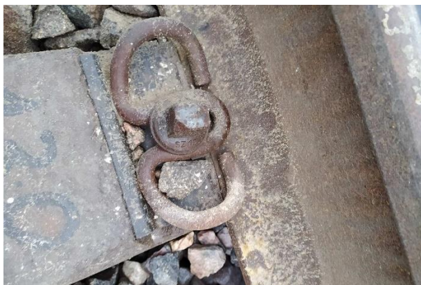
Фото 3.4. Пантаївка –Зім'яття головки шурупів колійних типу Ss 35.
