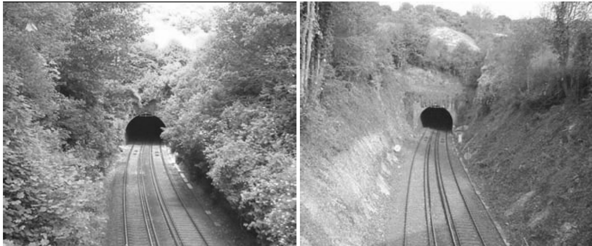
Рис. 1. Профилактическое обслуживание включает очистку от растительности
