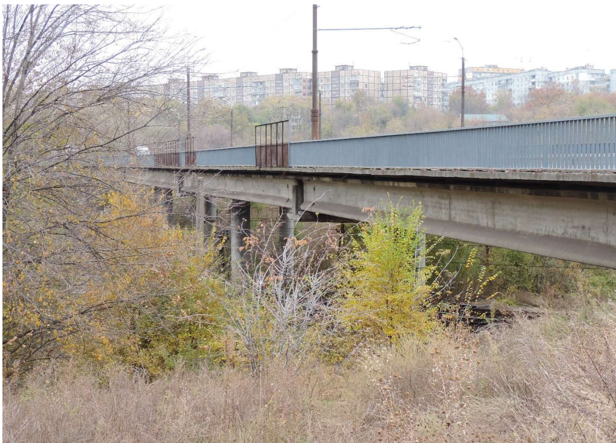
Рисунок 1.1 – Загальний вигляд шляхопроводу
