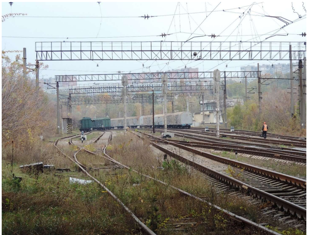
Рисунок 1.3 – Вигляд залізничної дороги під шляхопроводом
