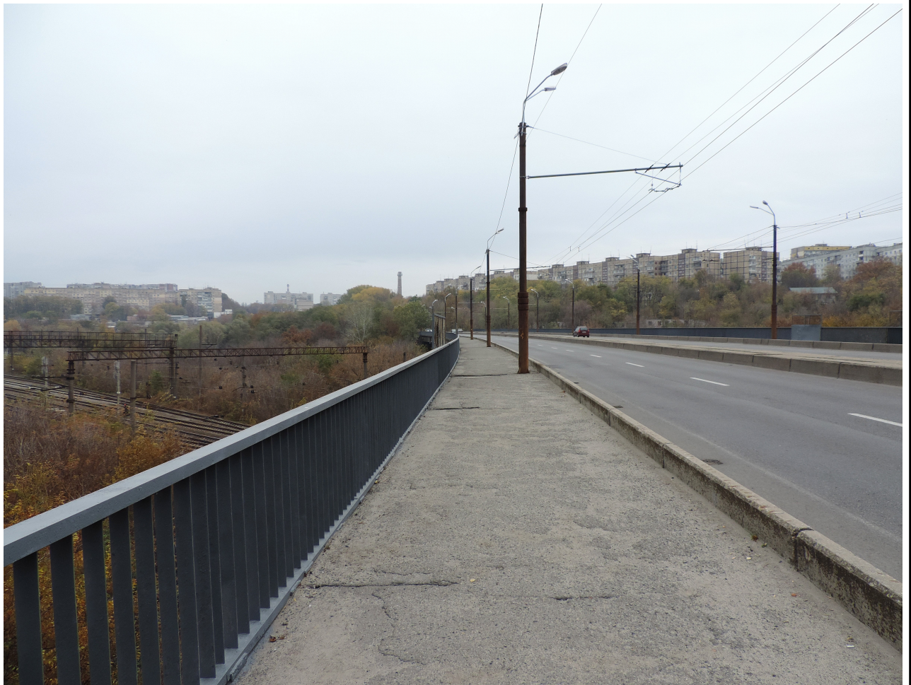
Рисунок 1.4 – Загальний вигляд пішохідної зони шляхопроводу
