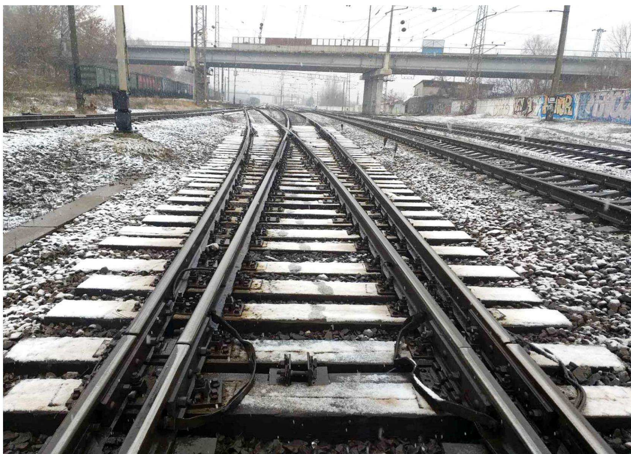
Рис. 1.4 Стрілочний перевід проєкт 2889 вкладений в криву ділянку колії
