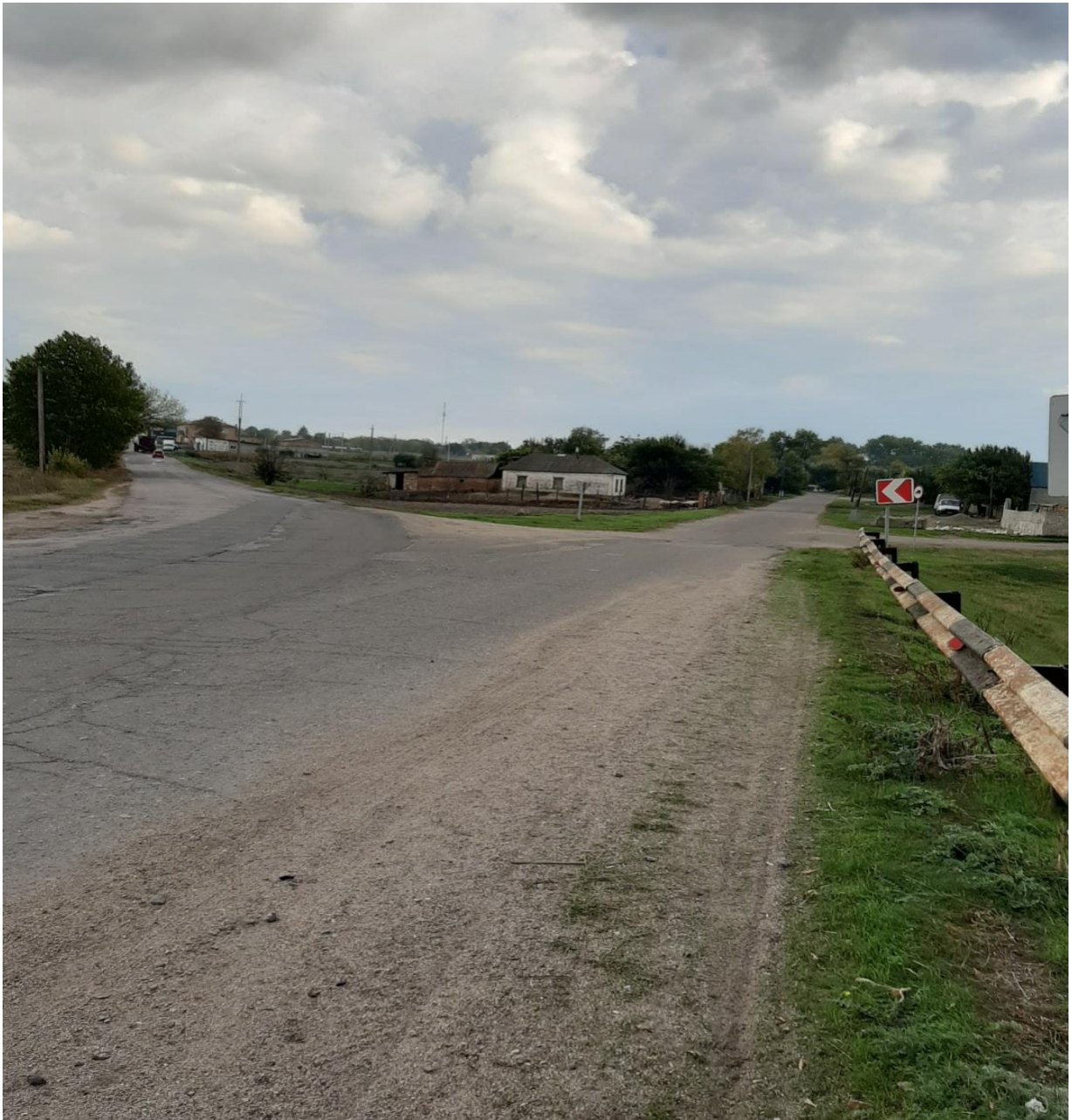
Рисунок 1.7 – Вид на проїзну частину підходу до мосту з боку с. Аджамка.
