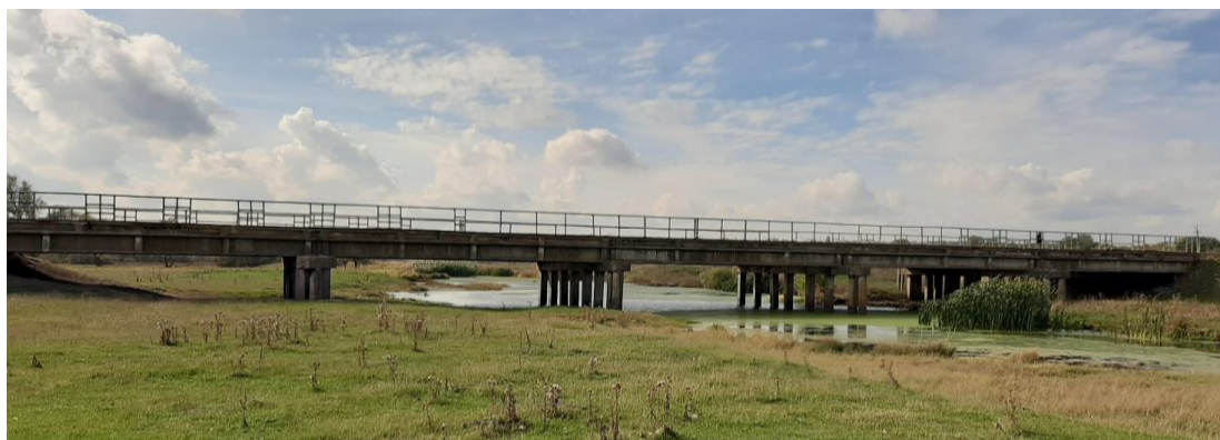
Рисунок 1.1 – Загальний вид мосту
