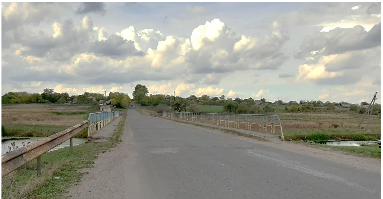
Рисунок 1.5 – Загальний вид на проїзну частину мосту з боку с. Аджамка
