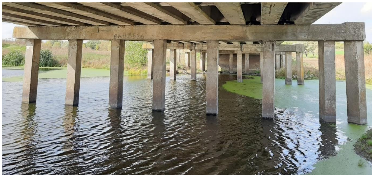
Рисунок 2.7 – Сліди вилугування і діяльності мікроорганізмів на поверхні ригеля опори № 3.
