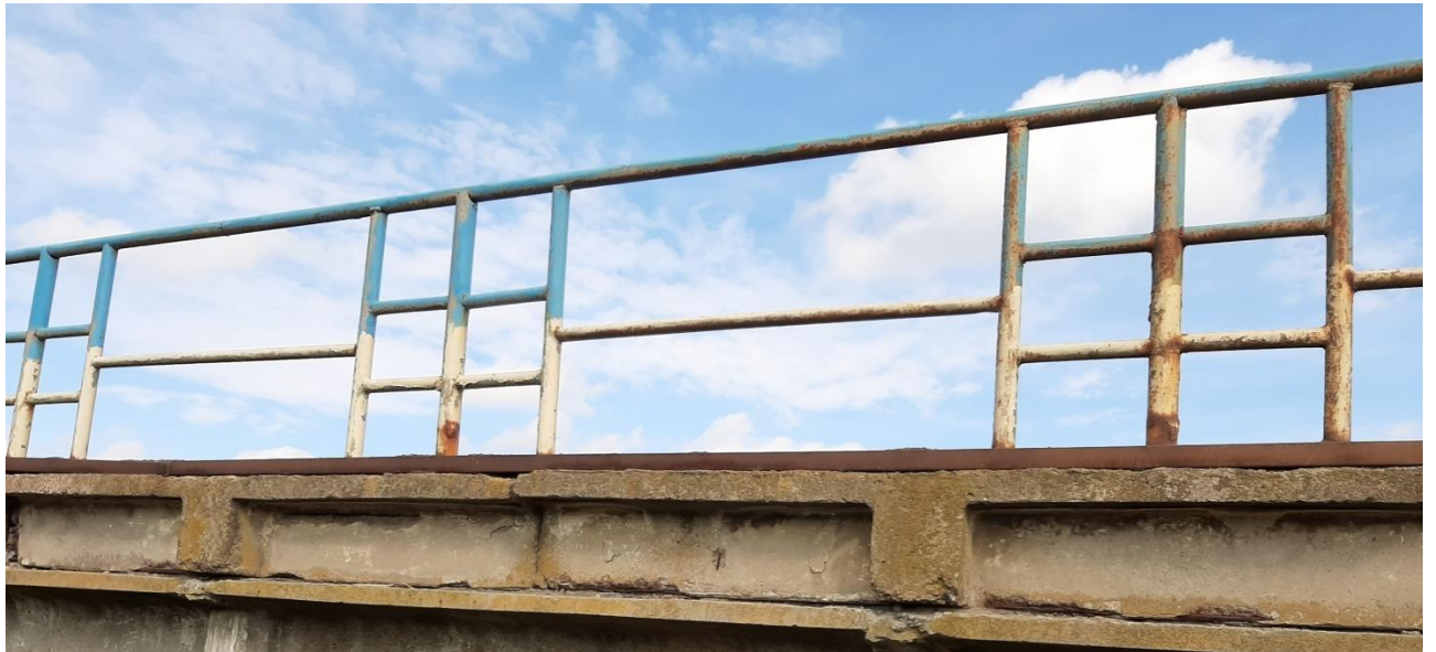
Рисунок 1.6 – Перильна огорожа правого тротуару
