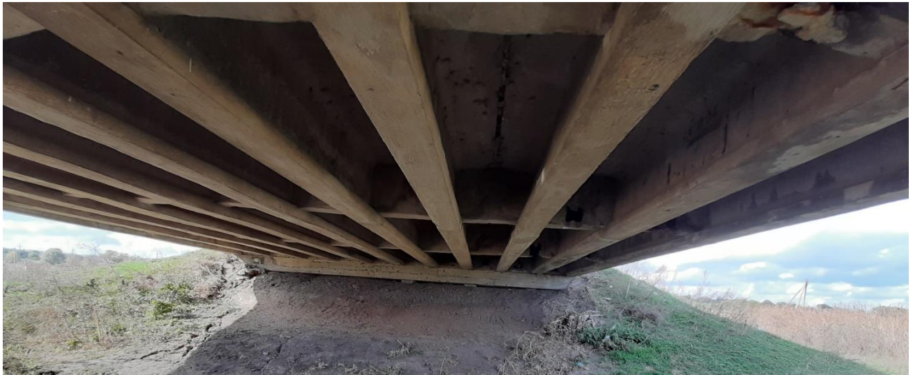
Рисунок 1.3 – Прогонова будова 0-1. Вид знизу на стоян №0
