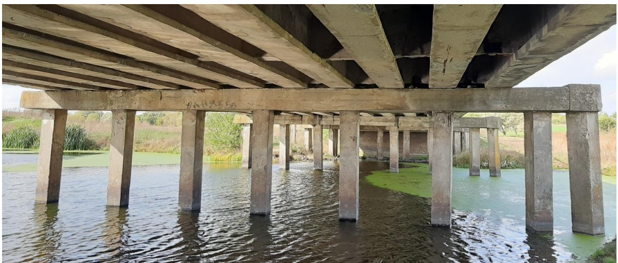
Рисунок 1.4 – Загальний вид проміжної опори № 3
