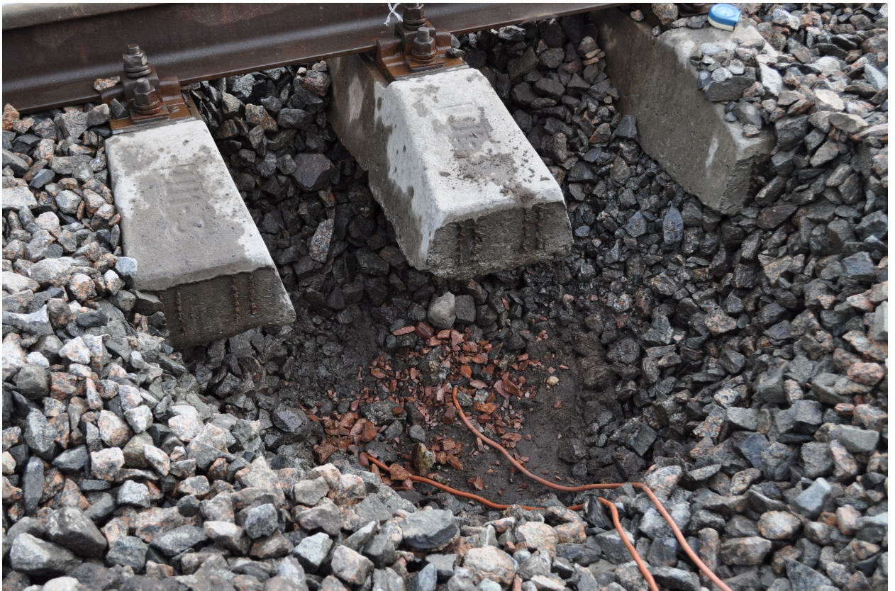
Рис. Д.3 – Встановлення 1-го рівня месдоз
