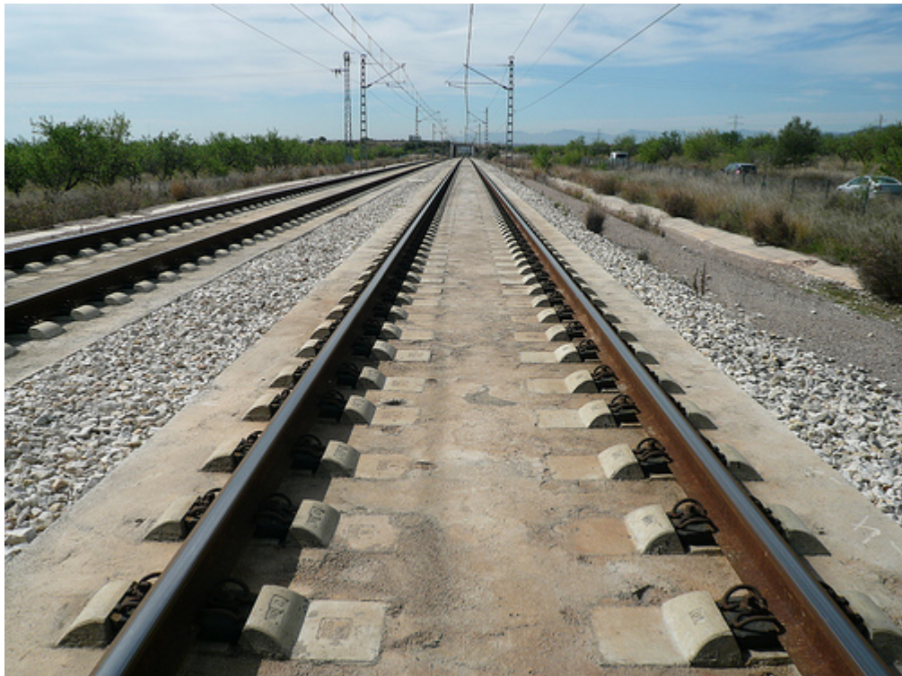
Рисунок 5.18 – Реальний вигляд безбаластної конструкції колії Rheda [198]
