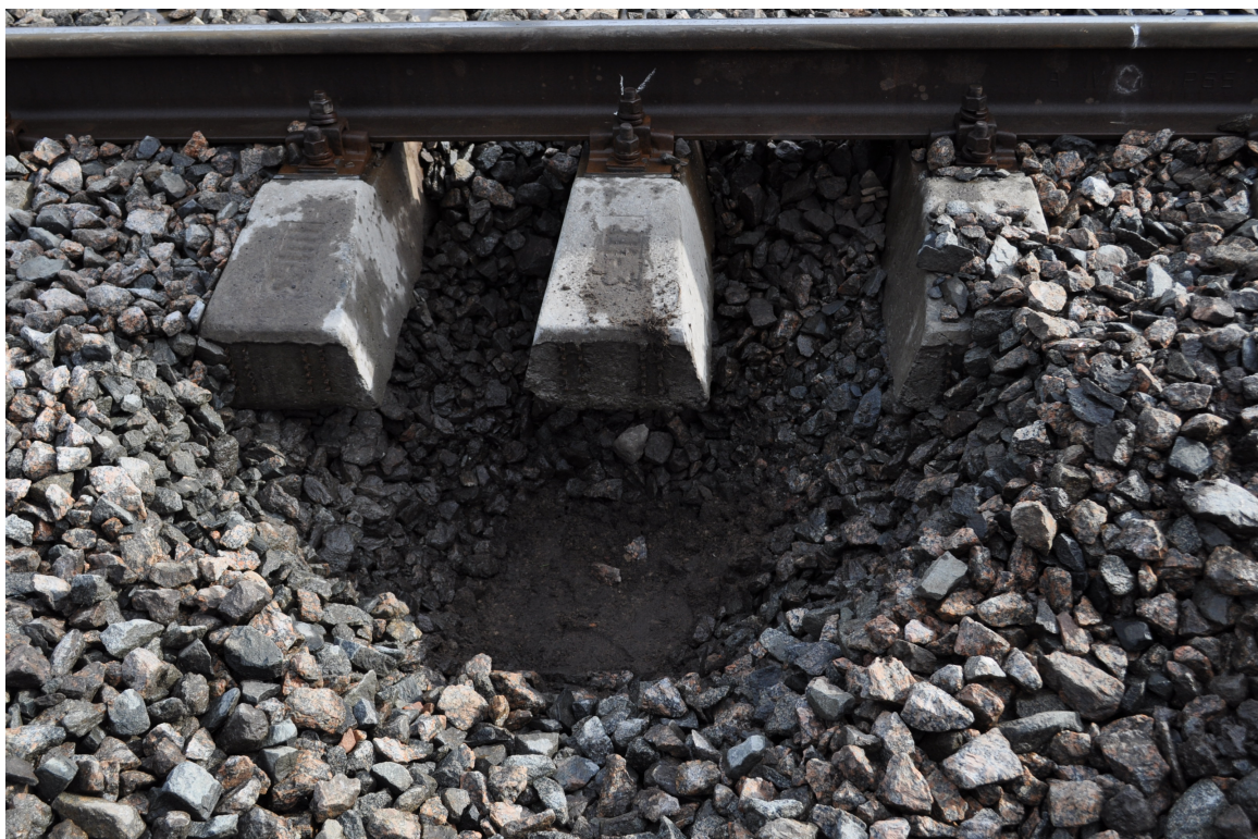
Рис. Д.1 – Підготовка місця для встановлення месдоз
