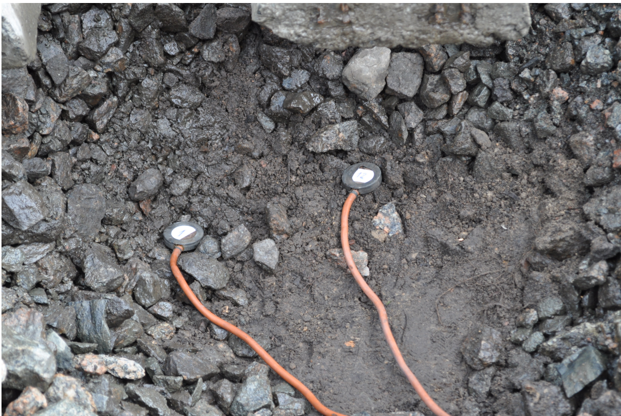
Рис. Д.5 – Встановлення 2-го рівня месдоз
