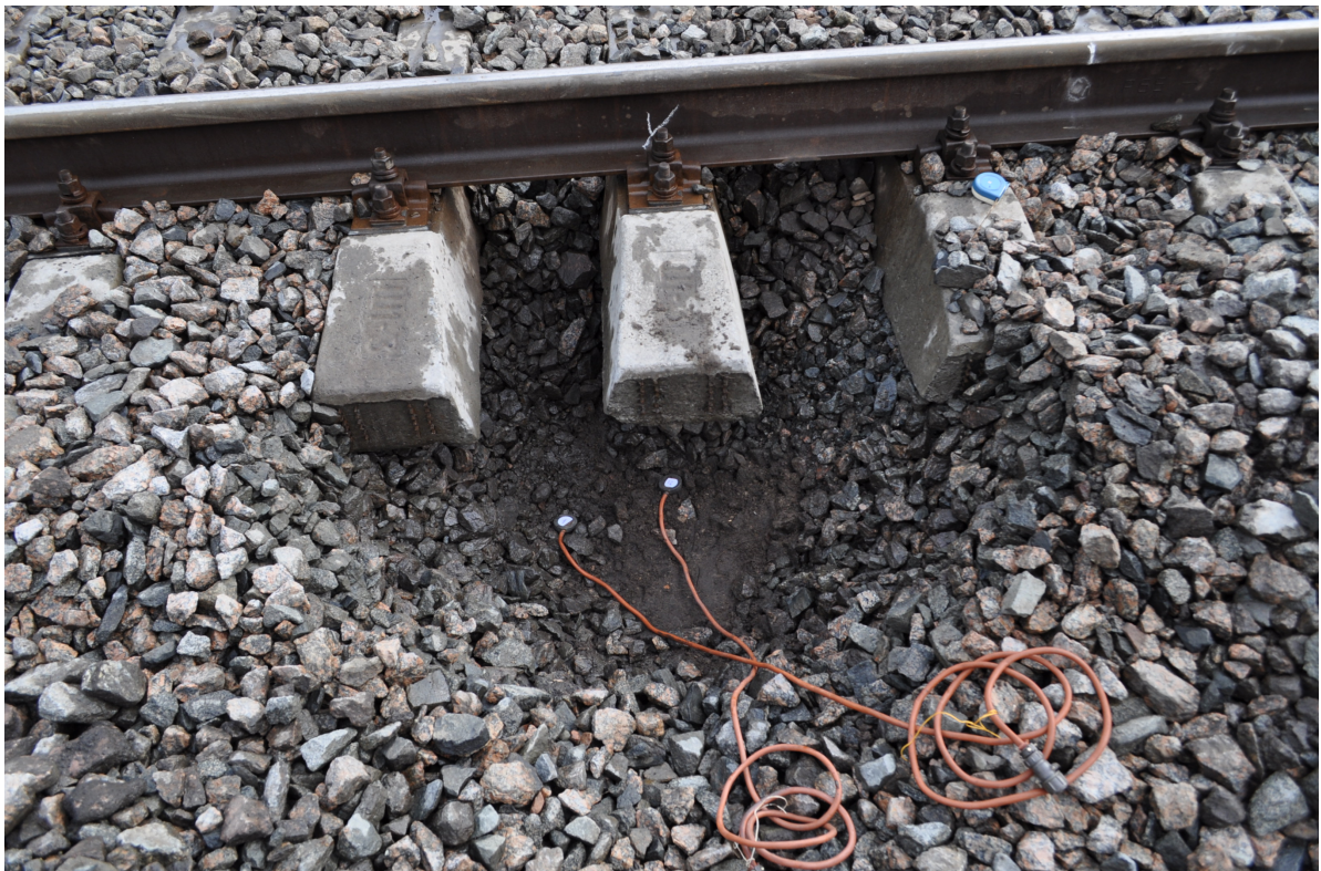
Рисунок 4.21 – Приклад встановлення месдоз на дослідній ділянці
