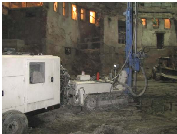
Рис. 3. Устройство буроинъекционных свай для противофильтрационной ванны
