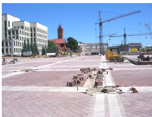
Рис. 7. Общий вид в стадии завершения строительства
