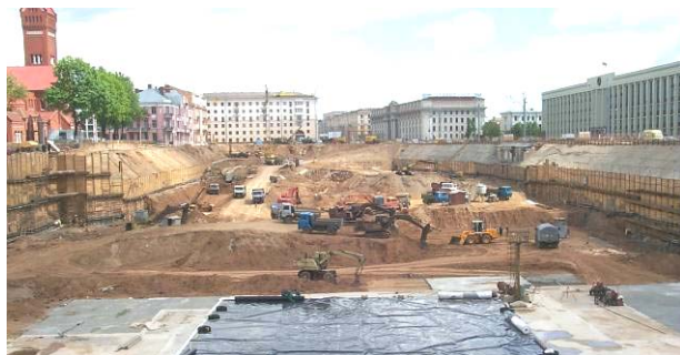
Рис. 2. Разработка и крепление стен котлована
