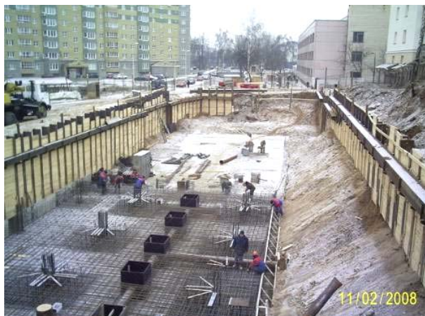
Рис. 6. Безанкерное свайно-балочное крепление глубокого котлована
