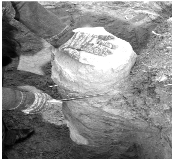
Рис. 1. Ґрунтоцементний елемент діаметром 200 мм в масиві ґрунту
