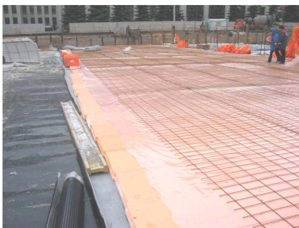
Рис. 6. Устройство гидроизоляции сооружения
