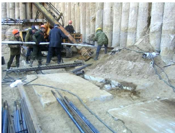
Рис. 9. Сборка анкерных тяг по а.с. № 1392203: а) – на дне котлована; б) – погружение в скважину
