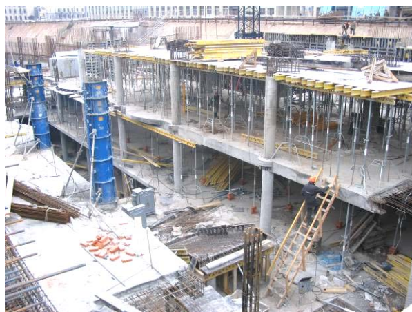
Рис. 3. Использование опалубки типа PERI
