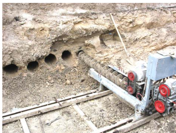
Рис. 1. Бурение цилиндрических скважин со стороны котлована под подошвой ленточного фундамента
