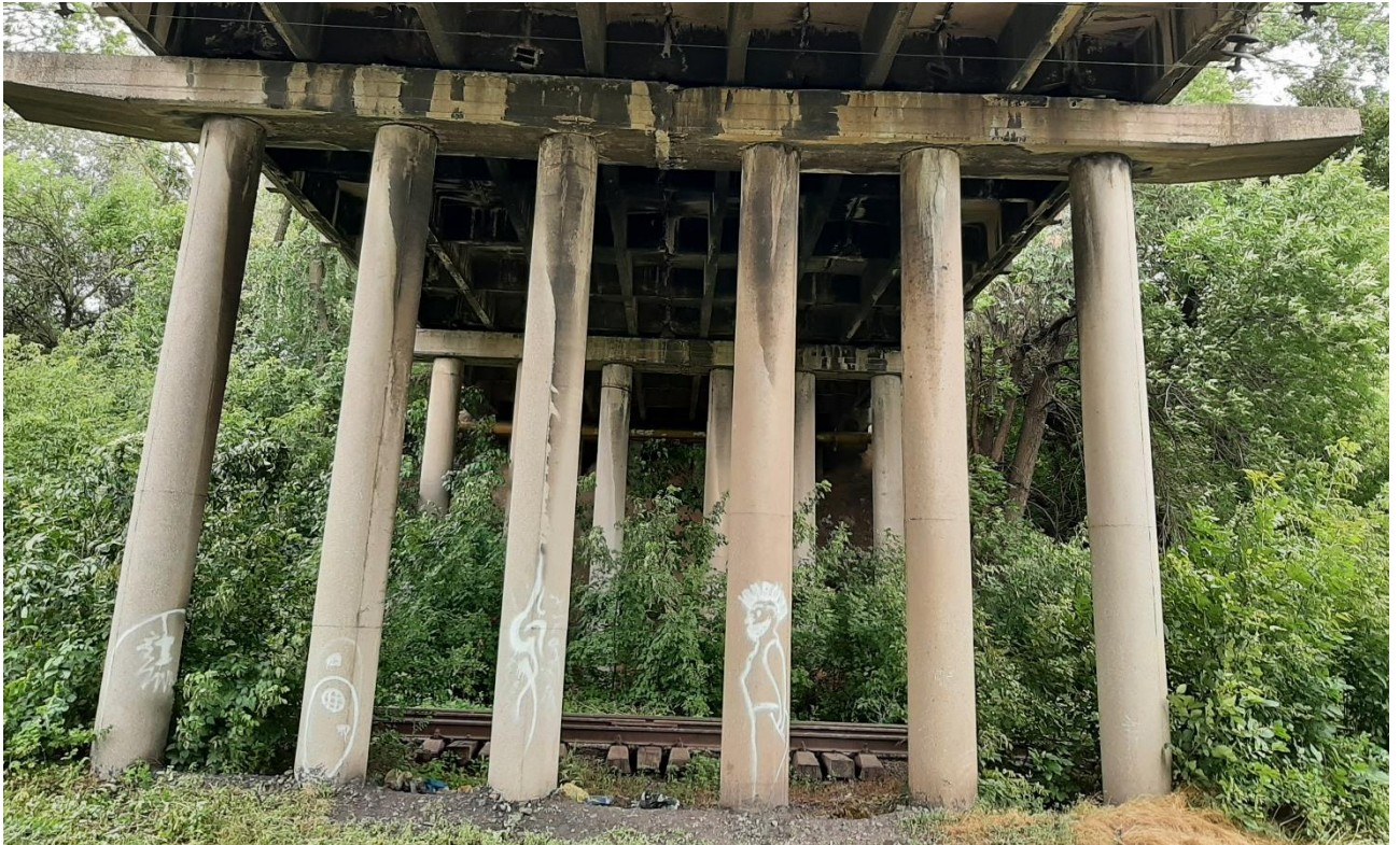
Рисунок 1.4 – Загальний вид на проміжну опору ОП3 з боку опори ОП4
