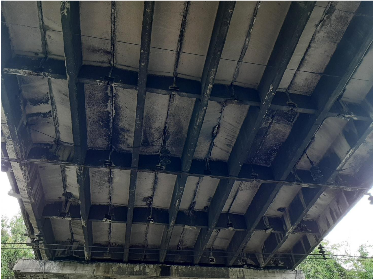
Рисунок 1.3 – Прогонова будова 3-4. Вид на опору ОП 3
