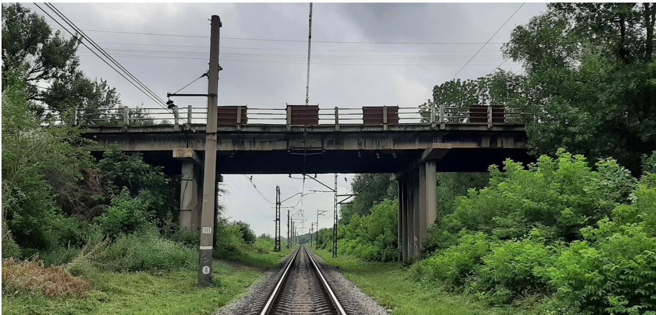
Рисунок 1.1 – Загальний вигляд шляхопроводу
