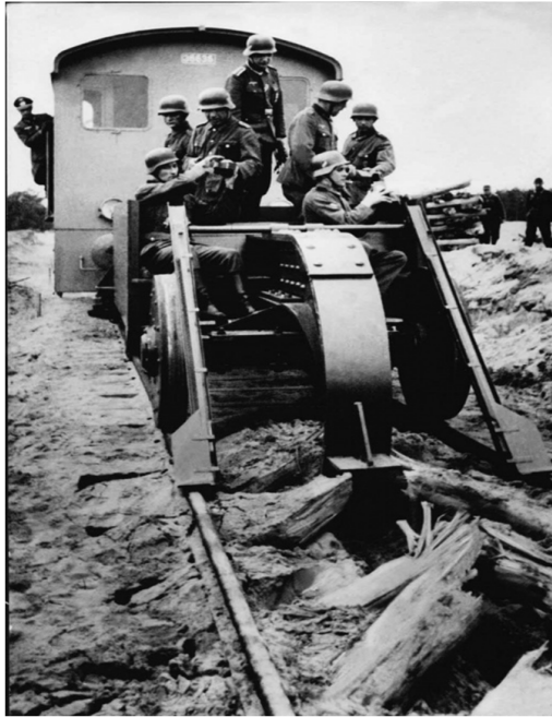
Рис. 7. Шляхоруйнувач «Гак».
