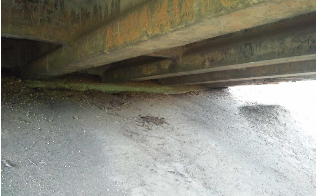
Рисунок 1.16 – Вид на опору №1
