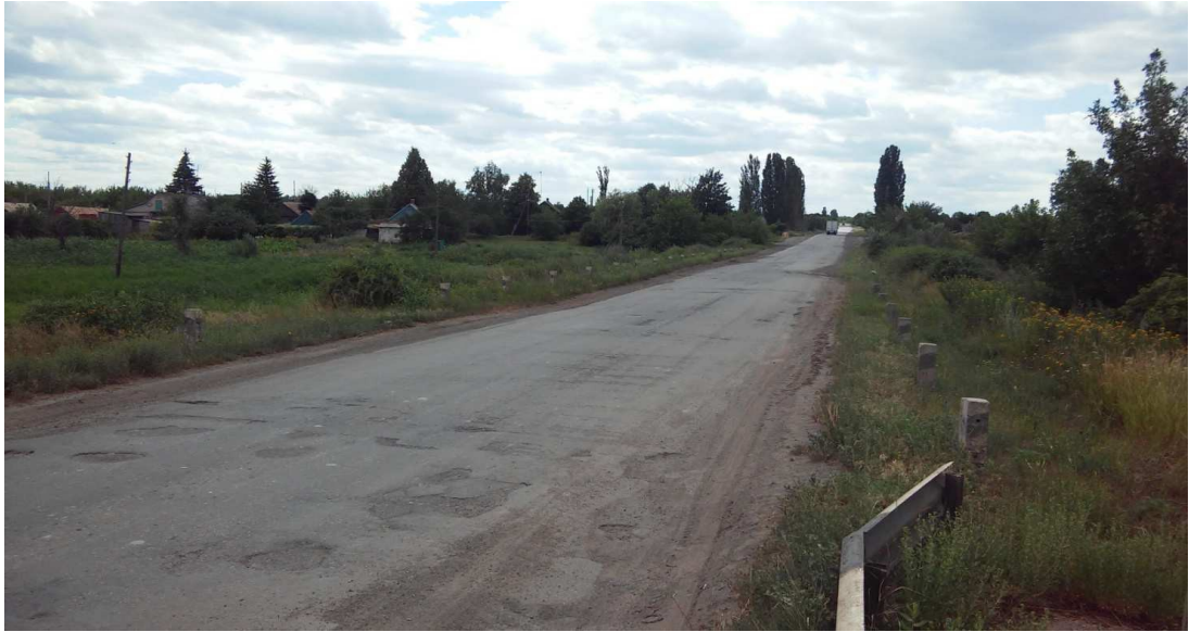
Рисунок 1.22. Вид на проїзну частину підходу до мосту з боку КПП «Танюшівка».
