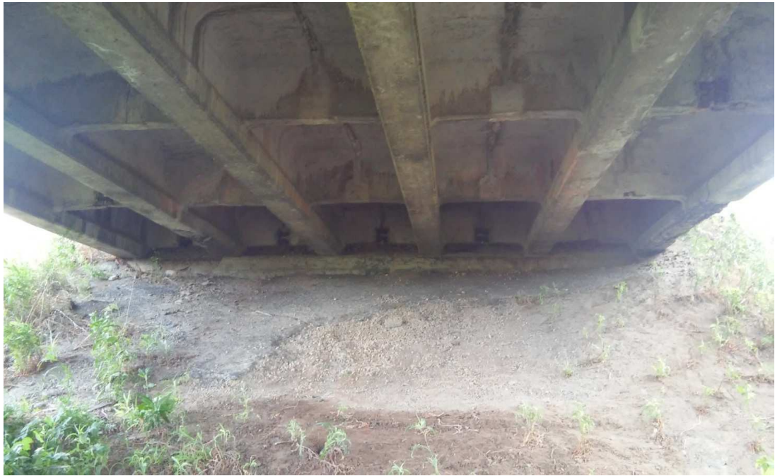
Рисунок 1.19 – Вид на опору №4
