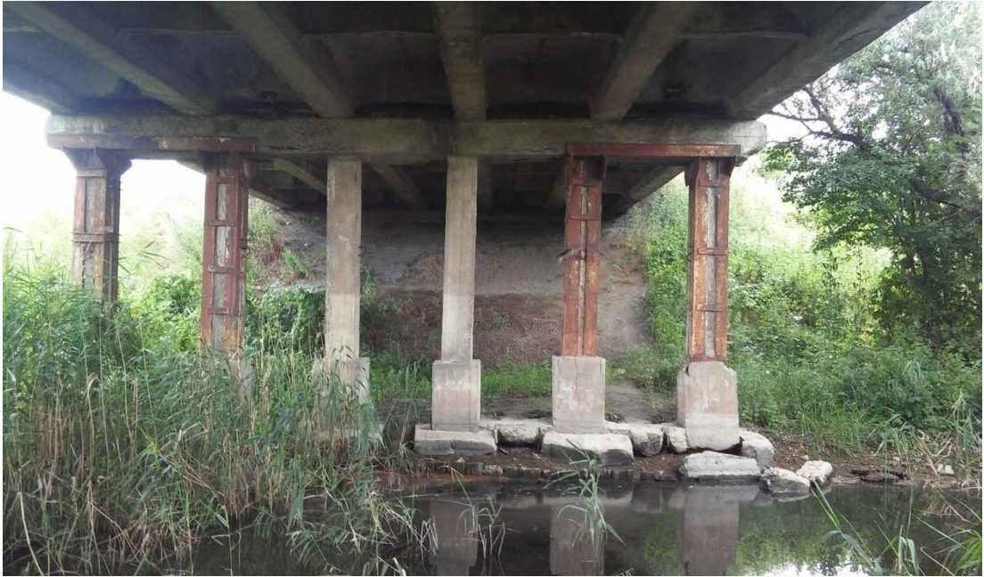
Рисунок 1.18 – Вид на опору №3
