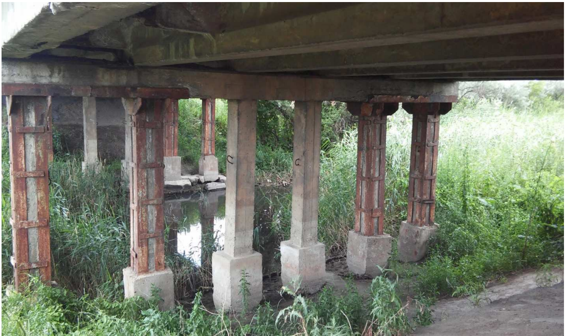
Рисунок 1.17 – Вид на опору №2
