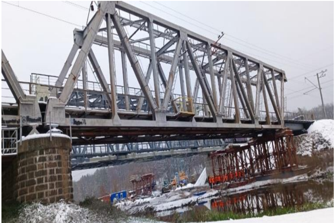
Рисунок 3.18 – Відновлення залізничного мосту за тимчасовою схемою
