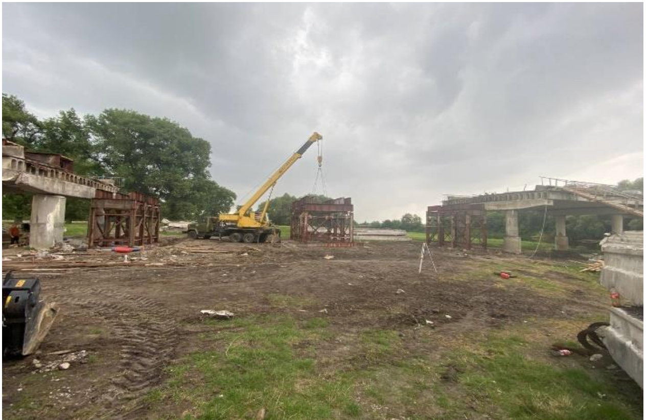
Рисунок 3.14 – Встановлення надбудов опор за допомогою стрілового крану
