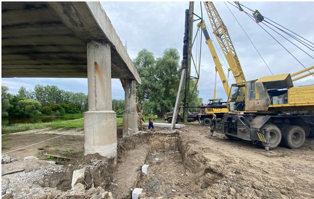
Рисунок 3.12 – Забивка палів агрегатом УСА
