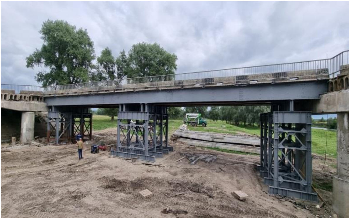
Рисунок 3.15 – Загальний вид відновленого мостового переходу
