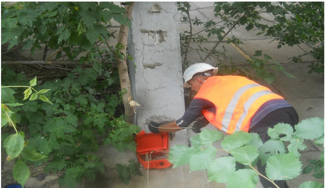
Рисунок 2.5 – Проведення дослідження стану залізобетонних споруд з використанням ультразвуку
