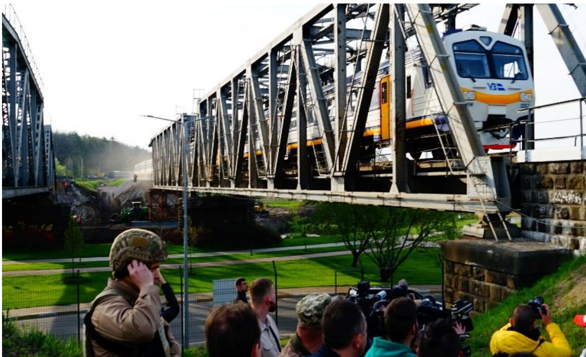
Рисунок 3.19 – Відкриття залізничного руху по відновленому мосту
