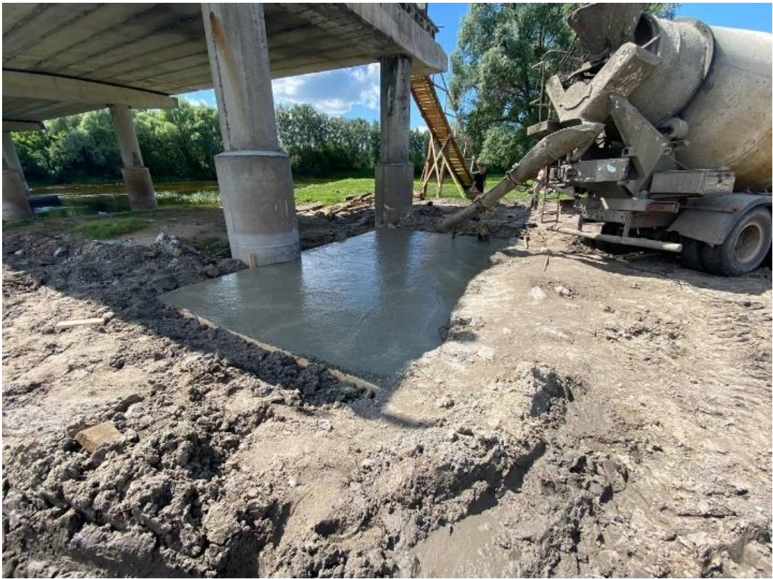
Рисунок 3.13 – Улаштування монолітного залізобетонного ростверку
