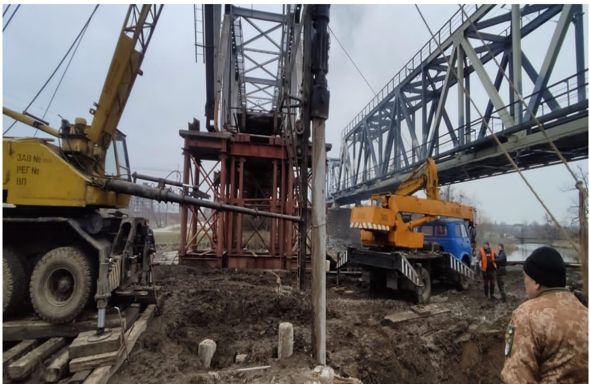
Рисунок 3.17 – Влаштування додаткового пального фундаменту
