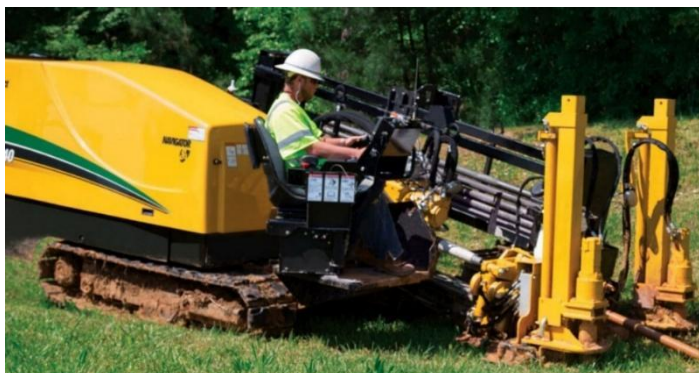
Рис. 1.3. Установка ГСБ фірми Vermeer
