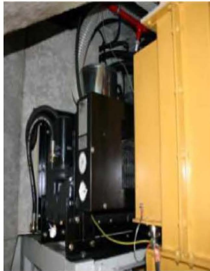
Рисунок 2.38 - Вид головного випрямляча і повітряного компресора
