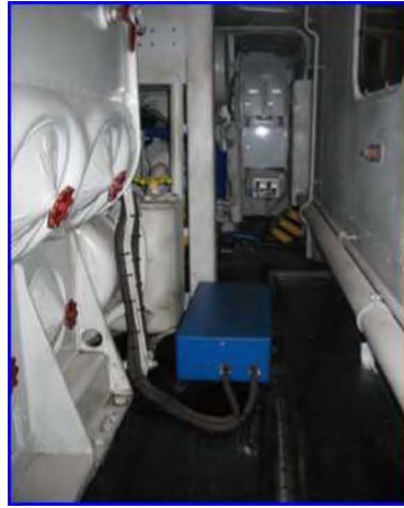
Рисунок 2.16 - Вид модернізованого моторного відсіку тепловоза М62М
