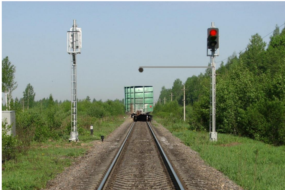
Рисунок 2.10 – Можливе розташування системи КВПВ на щоглі вихідного світлофору
