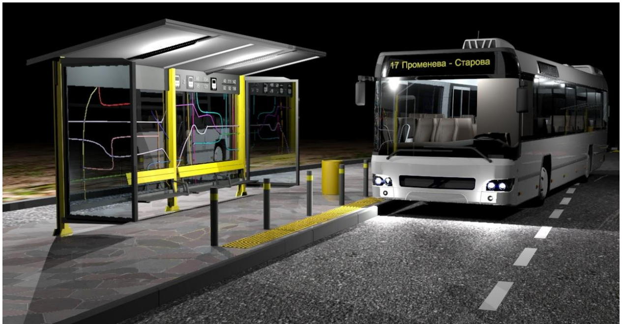
Рисунок 2.25 – На візуалізації зупинки запроектовано автопавільйон з нічним освітленням та лавками. На посадковому майданчику передбачено встановлення урни та боларди з попереджувальною тактильною смугою
