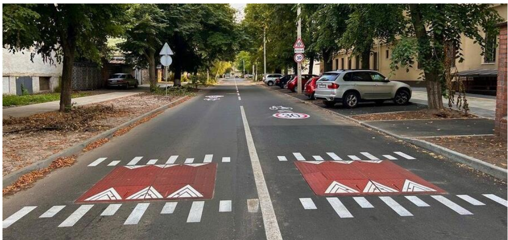
Рисунок 1.21 – Гумовий дорожній пагорб (берлінська подушка швидкості)
