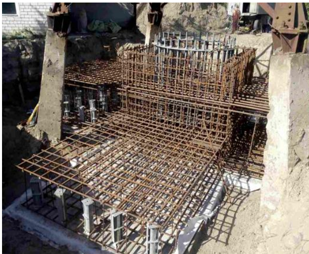
Рис. 13. Розміщення паль в тілі просторового армокаркасу в цілому
