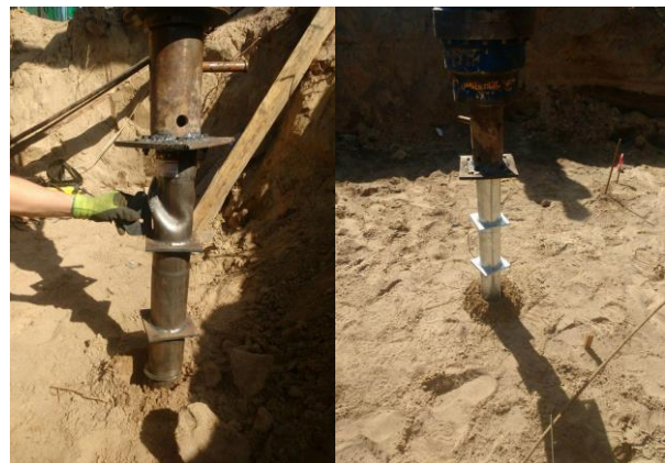
Рис. 10. Втрата стійкості оголовка палі під час занурення
