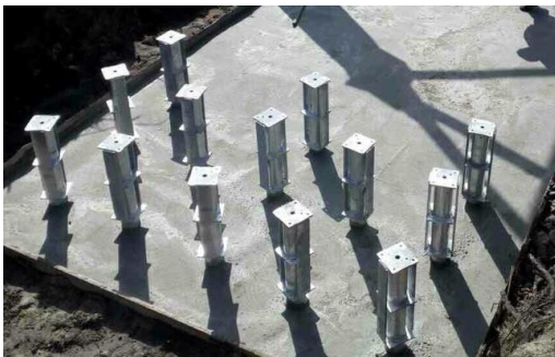
Рис. 11. Підсилення оголовків палей
