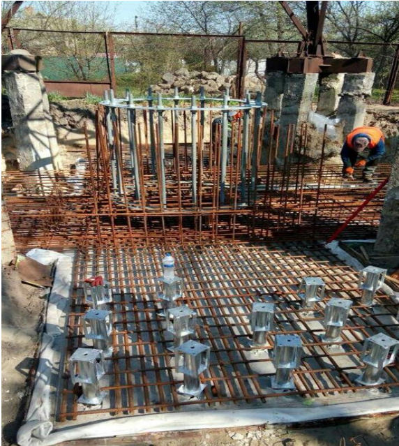
Рис. 12. Розміщення паль відносно нижньої сітки армокаркасу
